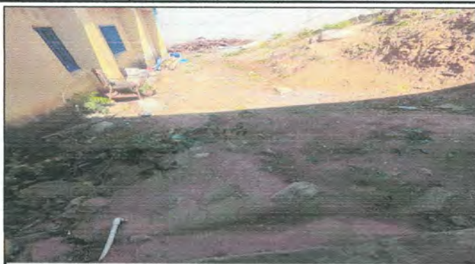
Renglon 10. Piso de concreto frente a salon de parvulos
