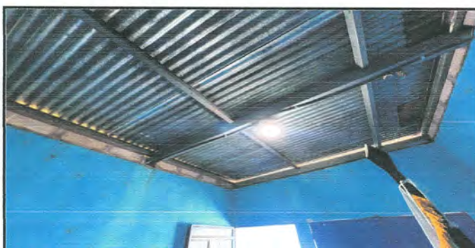
Foto 5: Lamina con Goteras y Area de Bodega de Alimentos (Cielo Falso) y lamina troquelada calibre 26
