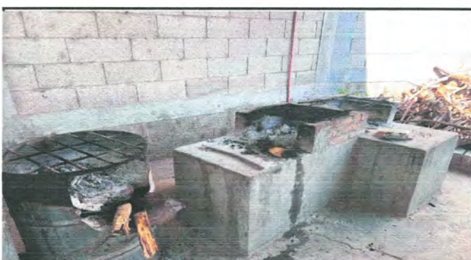
Foto 4: Estufa Artesanal demasiado pequeña (RENGLON 8.1) (2.1 esto para las ornillas) + (un meson de 0.9 mt de largo) ( 0.90mt de ANCHO TOTAL ) (Renglon 8.4, Campana o chimenea sobre poyeton, 2.1 de largo por 0.6 de ancho "comprende unicamente ornillas) (0.60 DE ANCHO A PETICION DE PADRES)
