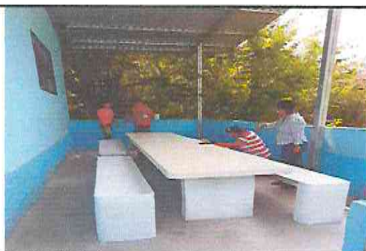
Foto 15: Sustitución de la mesa de madera por concreto
