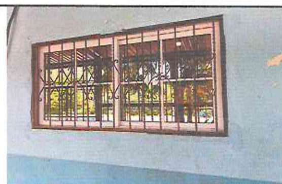
Foto 16: Reparación e instalación de ventana por PV C
