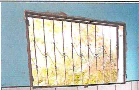
Foto 9: Reparación de ventana
