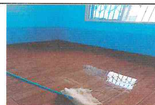
Foto 18: Sustitución de piso de concreto por piso cerámico
