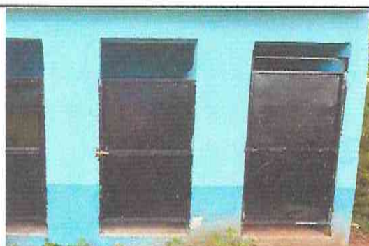
Foto 17: Reparación de puerta de sanitario
