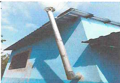
Foto 11: Reparación e instalación de chimenea
