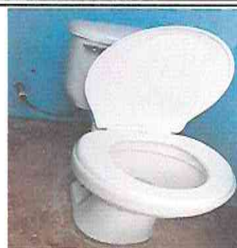
Foto 8: Sustitución de sanitario
