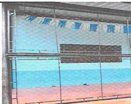
Foto 4: Mantenimiento de malla del área del corredor
