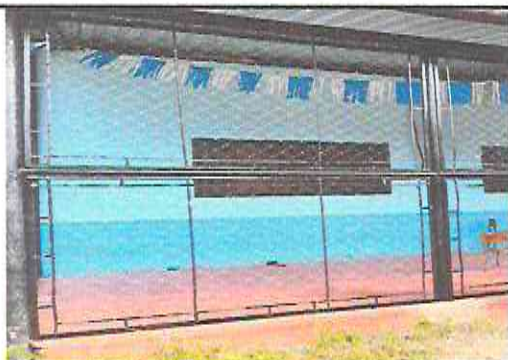
Foto 3: Mantenimiento de puerta de malla
