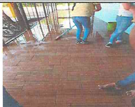
Foto 2: Sustitución de piso de concreto del corredor por piso cerámico
