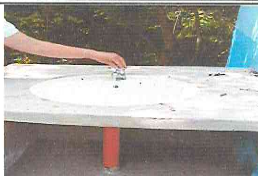
Foto 14: Reparación e instalación de lavamanos
