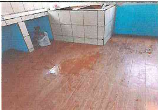
Foto 13: Reparación e instalación de piso cerámico en cocina
