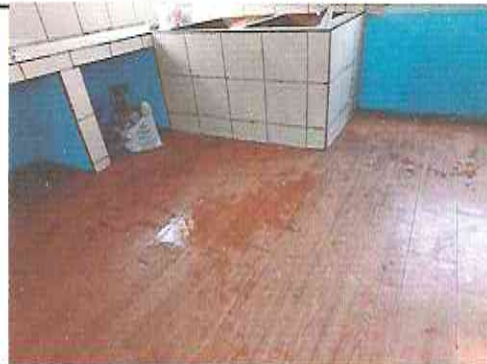
Foto 10: Instalación de azulejo en gabinetes
