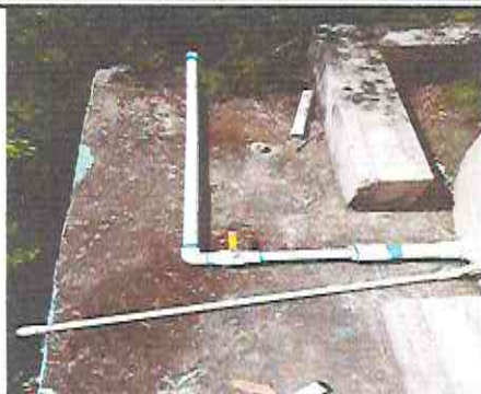
Foto 7: Cambio de tubería de pozo para área de sanitarios y cocina
