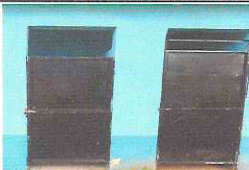
Foto 5: Mantenimiento de puerta de aula y soldadura
