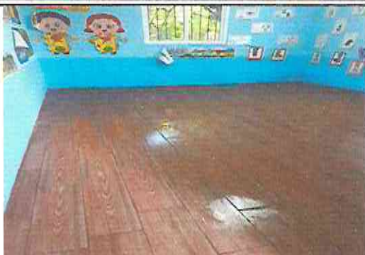
Foto 1: Sustitución de piso de concreto de aula por piso cerámico
