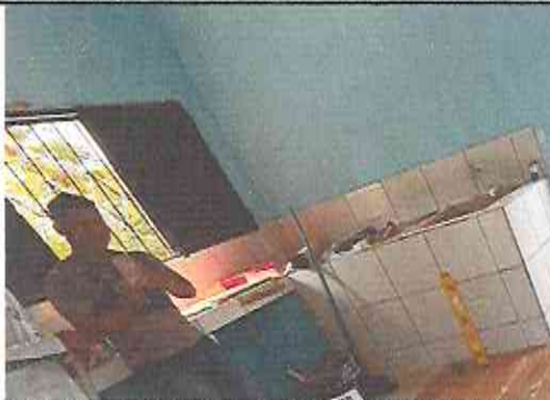
Foto 13: Reparación e instalación de piso cerámico en cocina
