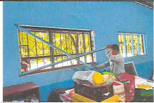
Foto 16: Reparación e instalación de ventana por PV C
