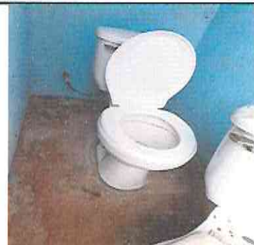
Foto 8: Sustitución de sanitario
