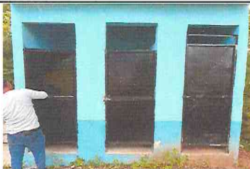
Foto 17: Reparación de puerta de sanitario
