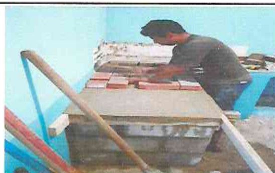
Foto 12: Reparación e instalación de plancha en polletón
