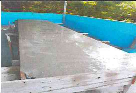
Foto 15: Sustitución de la mesa de madera por concreto
