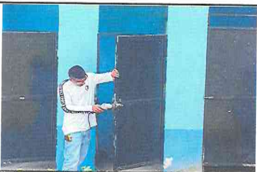
Foto 5: Mantenimiento de puerta de aula y soldadura
