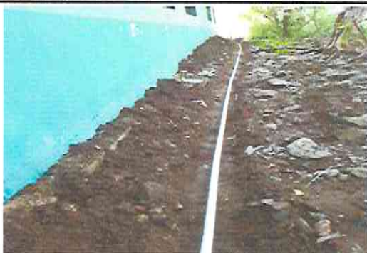
Foto 7: Cambio de tubería de pozo para área de sanitarios y cocina
