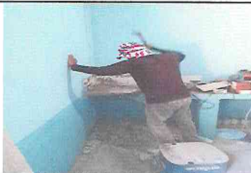
Foto 11: Reparación e instalación de chimenea
