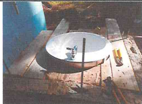
Foto 14: Reparación e instalación de lavamanos
