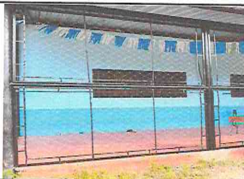
Foto 4: Mantenimiento de malla del área del corredor
