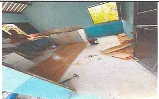
Foto 18: Sustitución de piso de concreto por piso cerámico
