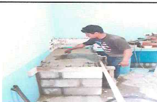
Foto 10: Instalación de azulejo en gabinetes
