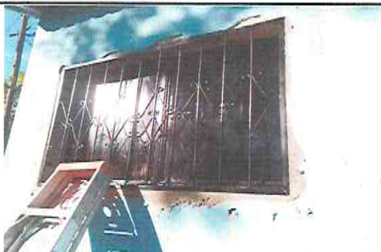
Foto 9: Reparación de ventana
