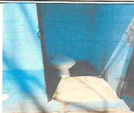
Foto 8: Sustitución de sanitarios
