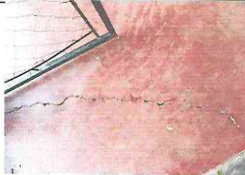
Foto 2: Sustrución de piso de corredor por piso cerámico
