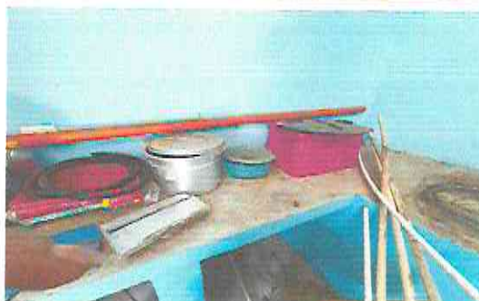
Foto 10: Instalación de azulejo en gabinetes
