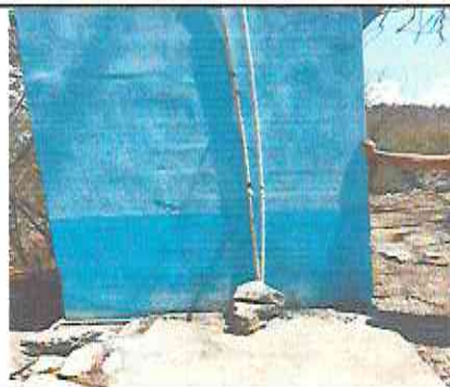
Foto 14: Reparación e instalación lava manos
