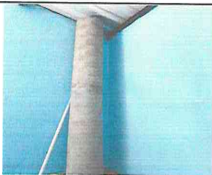
Foto 11: Reparación e instalación de chimenea
