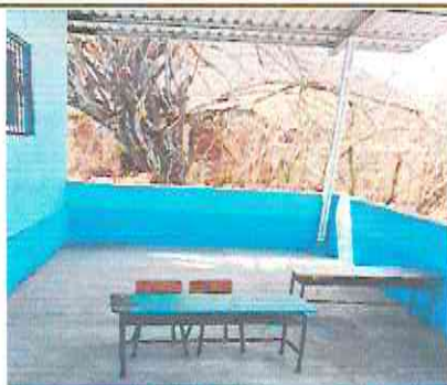
Foto 15: Sustitución de la mesa de madera por concreto
