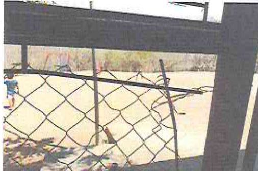
Foto 4: Mantenimiento de malla del área del corredor
