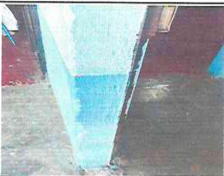
Foto 5: Mantenimiento de puerta de aula y soldadura
