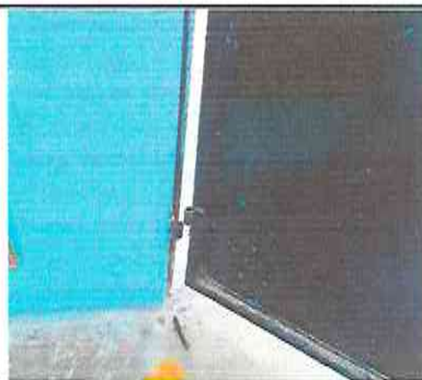
Foto 17: Reparación de puerta de sanitario
