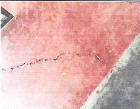
Foto 1: Sustrución de piso de aula por piso cerámico
