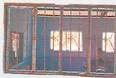
Foto 16: Reparación e instalación de ventana por PVC
