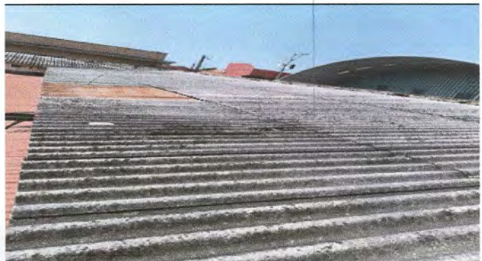
Foto 4: Sustrucción de lámina, por lámina troquelada de aluzinc calibre 26
