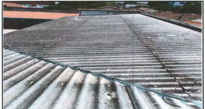
Foto 2: Sustrucción de lámina, por lámina troquelada de aluzinc calibre 26
