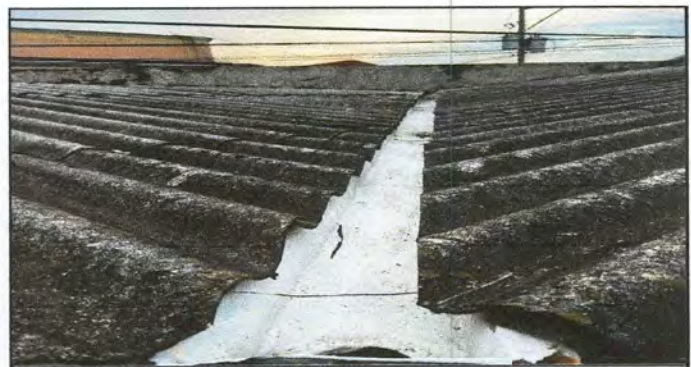
Foto 6: Suministro e instalación de canales para agua pluvial
