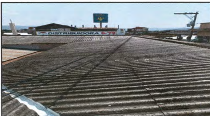
Foto 3: Sustrucción de lámina, por lámina troquelada de aluzinc calibre 26
