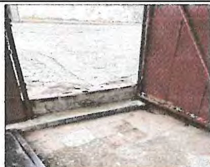
Foto 3: Fundición de Rampa de ingreso peatonal para eliminar las barreras que puedan obstaculizar el acceso
