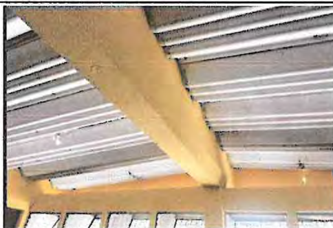
Foto 5: Sustrucción de lámina duralita por lámina aluzinc en los Salones de clases
