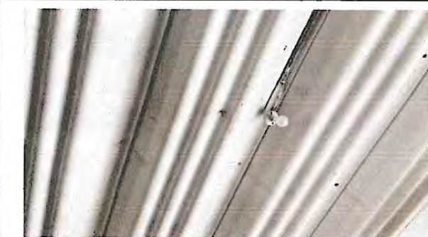
Foto 3: Instalación de cableado eléctrico, colocación de plafonera, focos, apagadores y tomacorrientes
