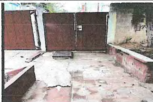
Foto 1: Colocación de rampa de acceso peatonal de entrada principal al Centro Educativo
