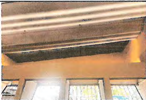
Foto1: Sustrucción de lámina duralita por lámina aluzinc en los salones de clases de Sexto Perito Sección C, D, y un modulo de Quinto sección D.
