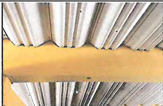
Foto 3: Fundición y nivelación de Vigas de concreto para soporte de estructura de metal
