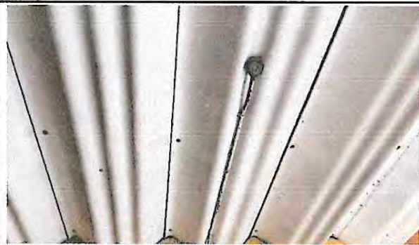
Foto 1: Instalación de cableado eléctrico, colocación de plafonera, focos, apagadores y tomacorrientes, en los 5 módulos de los salones de clases y pasillo
