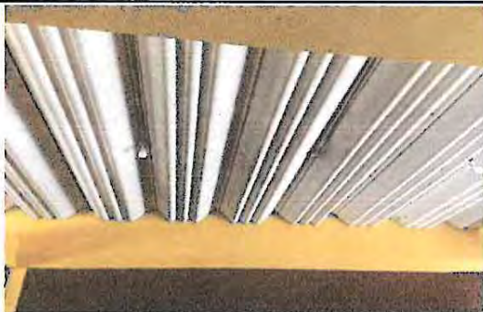
Foto 3: Continuando Sustitución de lámina duralita por lámina aluzinc
