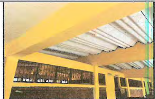
Foto 6: Sustrucción de estructura de soporte de metal en los salones de e clases
