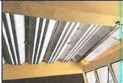
Foto 4: Sustrucción de estructura de soporte de metal en los salones de e clases
