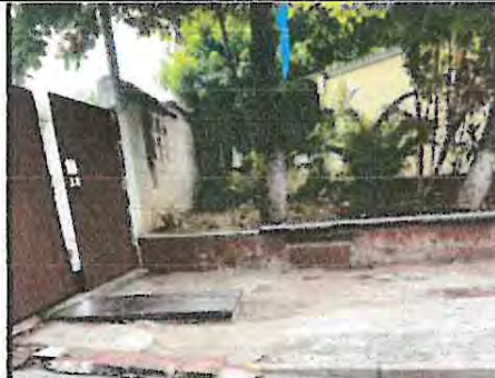
Foto 2: Fundición de Rampa para el ingreso peatonal entrada principal
