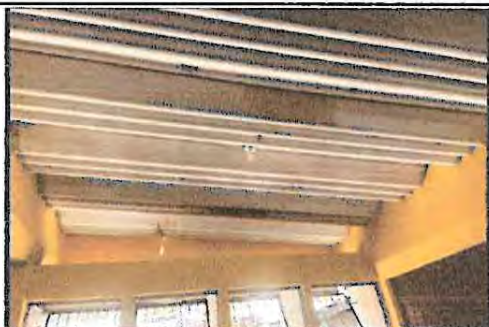
Foto 5: Continuando Sustitución de lámina duralita por lámina aluzinc
