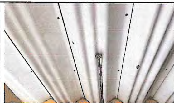
Foto 5: Instalación de cableado eléctrico, colocación de plafonera, focos, apagadores y tomacorrientes
