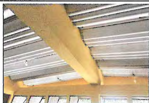
Foto 4: Continuando Sustitución de estructura de soporte de metal
