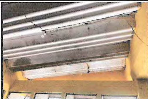
Foto 3: Sustrucción de lámina duralita por lámina aluzinc a salones de clases
