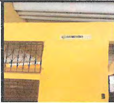
Foto 1: Continuando Sustitución de lámina duralita por lámina aluzinc en los salones de e clases de Sexto Perito Sección C, D, y un modulo de Quinto sección D.
