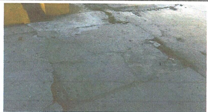
Foto 6: Sustitución de planchas de concreto en mal estado en el area de la cancha
