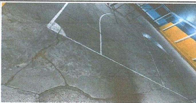
Foto 5: Sustitución de planchas de concreto en mal estado en el area de la cancha
