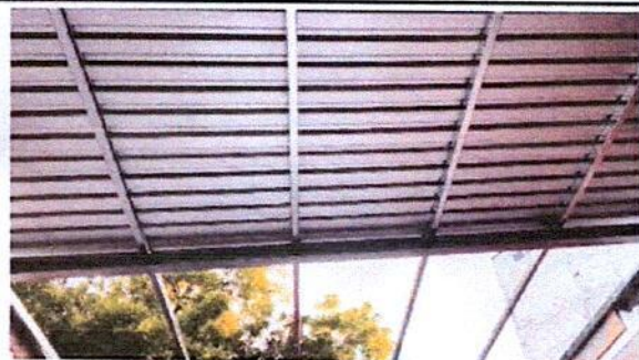
Foto3: Sigue la instalación de láminas en un módulo del Salón de Clases del Área de Carpintería
