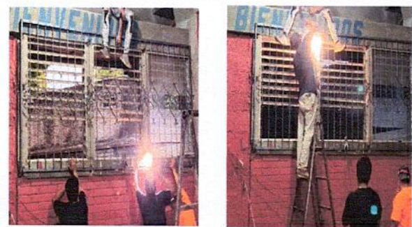
Foto 5: Sustitución e instalación del nuevo balcón en la ventana del fondo de la pared en el Módulo del Salón de Clases del Area de Carpintería de remozamiento
