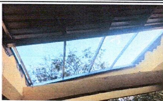
Foto2: Después de haber hecho la instalación de estructura de tubos y costaneras, se procedió la instalación de láminas en un módulo del Salón de Clases y pasillo de Segundo Grado Sección E.
