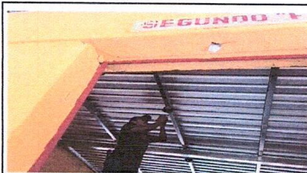
Foto 4: Así, luce el nuevo sistema instalado en los dos módulos de remozamiento
