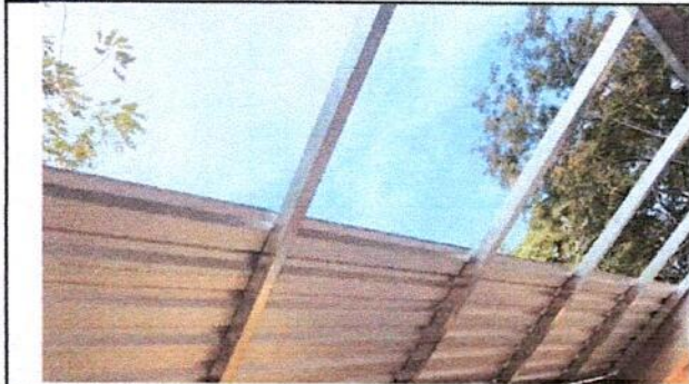
Foto1: Después de haber hecho la instalación de estructura de tubos y costaneras, se procedió la instalación de láminas en los 2 módulos del Salón de Clases y pasillo de Segundo Grado Sección F.
