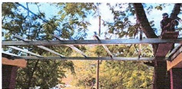
Foto1: Se realizó la instalación de estructura de tubos y costaneras en el módulo del pasillo que conduce hacia el Área de Segundo Grado Básico
