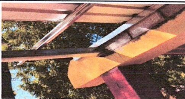
Foto4: Así quedó la nivelación de las vigas de agua pluvial del módulo de remozamiento del pasillo que conduce hacia el Área de Segundo Grado Básico
