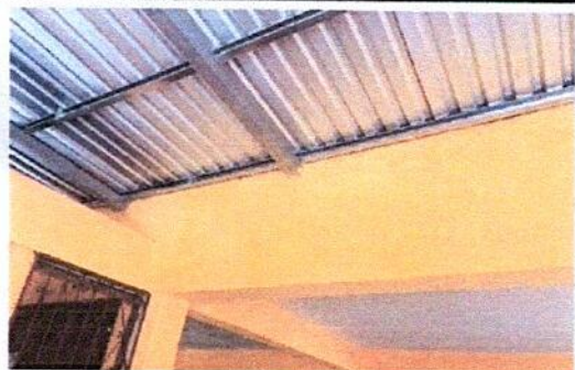
Foto3: Sigue la instalación de láminas en un módulo del Salón de Clases y pasillo de Segundo Sección E.
