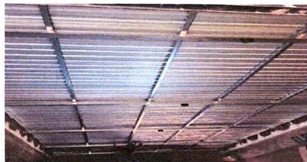
Foto 1: Realizando la instalación de sistema eléctrico en 1 modulo del Salón de Clases del Area de Carpintería
