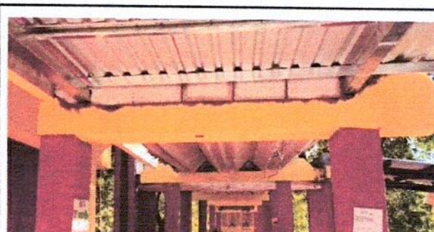
Foto4: Así quedó la nivelación de las vigas de agua pluvial del módulo de remozamiento del pasillo que queda enfrente del Salón de Conferencia
