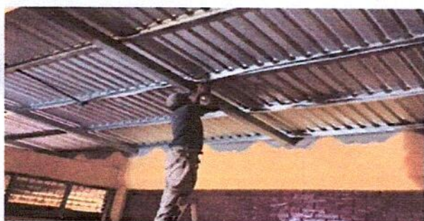
Foto 3: Continuando revisando la instalación de ducto y cableado eléctrico en el módulo de remozamiento
