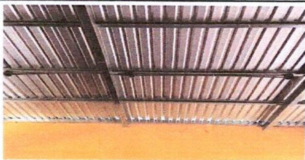
Foto 1: Realizando la instalación de sistema eléctrico en los 2 módulos del Salón de Clases y Pasillo de Segundo Grado Básico Sección F
