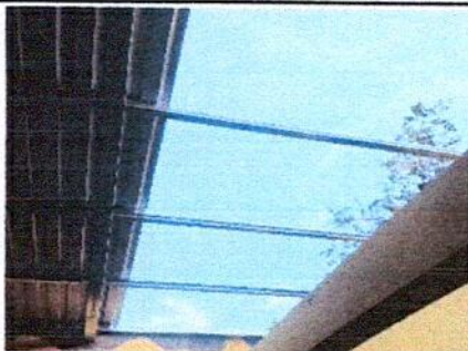
Foto1: Después de haber hecho la instalación de estructura de tubos y costaneras, se procedió la instalación de láminas en un módulo del Salón de Clases y pasillo de Segundo Grado Sección E.
