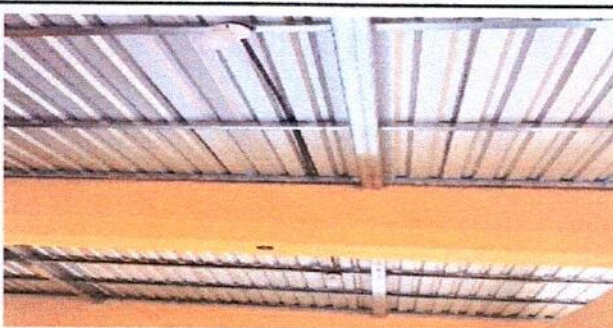
Foto 5: Así, luce el nuevo sistema eléctrico instalado en los 2 módulos de remozamiento del Salón de Clases de Segundo Grado Básico Sección F
