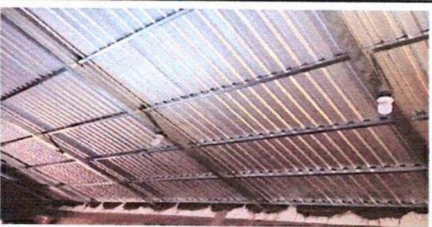
Foto 5: Así, luce el nuevo sistema eléctrico instalado en un módulo de remozamiento del Salón de Clases del Area de Carpintería
