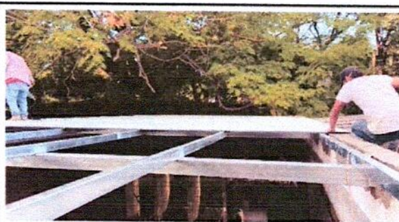
Foto4: Continuación de la instalación de láminas en un módulo del Salón de Clases del Área de Carpintería.
