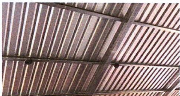
Foto 1: Realizando la instalación de sistema eléctrico en 1 modulo del Salón de Clases y Pasillo de Segundo Grado Básico Sección E
