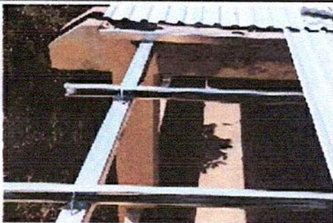
Foto3: Sigue la instalación de láminas en el Pasillo de Segundo Sección F.
