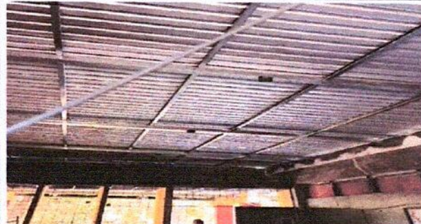
Foto 2: Revisando la instalación de ducto y cableado eléctrico en 1 módulo de remozamiento
