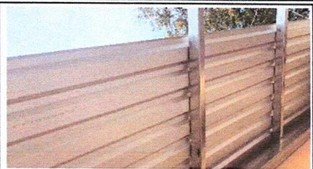
Foto2: Después de haber hecho la instalación de estructura de tubos y costaneras, se procedió la instalación de láminas en los 2 módulos del Salón de Clases y pasillo de Segundo Grado Sección F.
