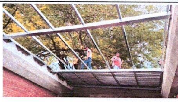
Foto2: Después de haber hecho la instalación de estructura de tubos y costaneras, se procedió a la instalación de láminas en un módulo del Salón de Clases del Área de Carpintería.
