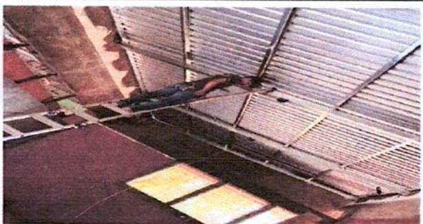
Foto 3: Continuando revisando la instalación de ducto y cableado eléctrico en 1 módulo de remozamiento
