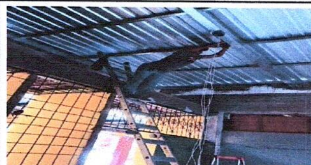
Foto 4: Así, luce el nuevo sistema instalado en un módulo de remozamiento
