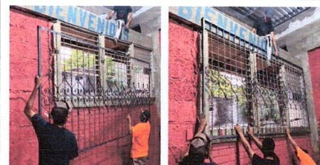
Foto4: Despejada el área, se procede a colocar el nuevo balcón en la ventana de la pared del fondo en el Módulo del Salón de Clases del Area de Carpintería de remozamiento
