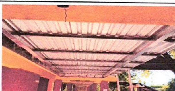
Foto 6: Vista final del techado del módulo de remozamiento del pasillo que queda enfrente del Salón de Conferencia
