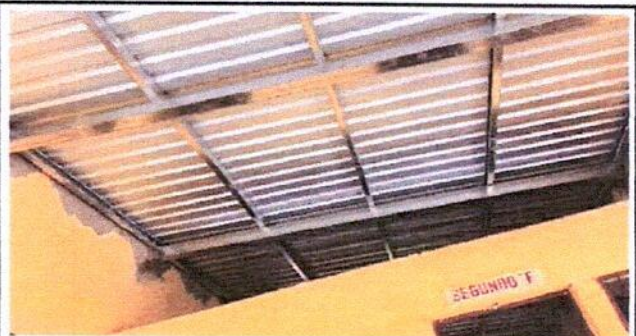
Foto4: Continuación de la instalación de láminas en los 2 módulos del Salón de Clases y pasillo de Segundo Sección F.
