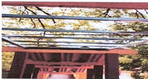
Foto2: Vista final de la instalación de tubos y costaneras en el módulo del pasillo que conduce hacia el Área de Segundo Grado Básico
