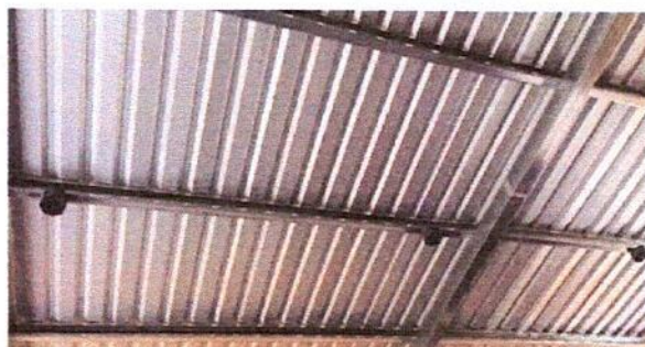
Foto 2: Revisando la instalación de ducto y cableado eléctrico en el módulo de remozamiento
