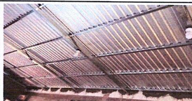
Foto 6: Final de la instalación de sistema eléctrico en los Módulos de remozamiento del Salón de Clases del Area de Carpintería
