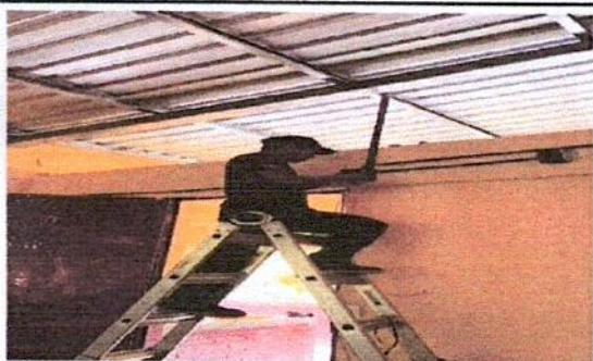
Foto 3: Continuando revisando la instalación de ducto y cableado eléctrico en los 2 módulos de remozamiento
