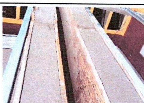
Foto 4: La acción de rellenado de las ondulaciones se hizo todos los canales de los 2 módulos del salón de clases y pasillo de Segundo Grado Sección F.
