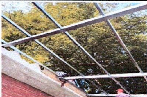
Foto 1: Después de haber realizado la demolición del techo de duralita, se procedió a hacer la instalación de los tubos y de las costaneras en un módulo del Salón de Clases de área de carpintería.
