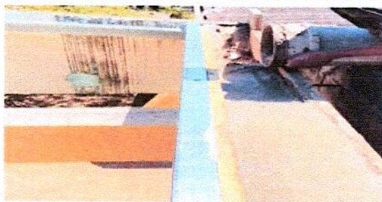
Foto 1: Después de haber hecho la demolición del techo y de haber instalado los tubos y costaneras, se procedió a restaurar los laterales de los canales de agua pluvial de un módulo de Salón y pasillo de Segundo Grado Sección E
