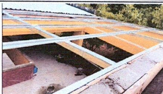
Foto 2: Después de haber realizado la demolición del techo de duralita, se procedió a hacer la instalación de los tubos y de las costaneras en módulo del salón y pasillo de Segundo Grado Sección E.
