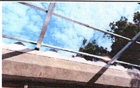
Foto 2: Después de haber realizado la demolición del techo de duralita, se procedió a hacer la instalación de los tubos y de las costaneras en un módulo del Salón de Clases de área de carpintería.
