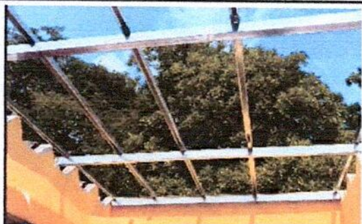
Foto 5: Instalación de tubos y costaneras en el módulo del Salón de Clases de Segundo Sección E, preparado para hacer la instalación de láminas
