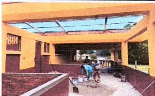
Foto 1: Después de haber hecho la demolición del techo y de haber instalado los tubos y costaneras, se procedió a restaurar los laterales de los canales de agua pluvial en el Salón de Clases de Segundo Grado Sección F
