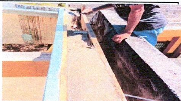
Foto 3: La reconstrucción los laterales de dichos canales, se hizo con cemento y arena, rellenando las ondulaciones donde se encontraba la duralita un módulo y pasillo de Segundo Grado Sección E.
