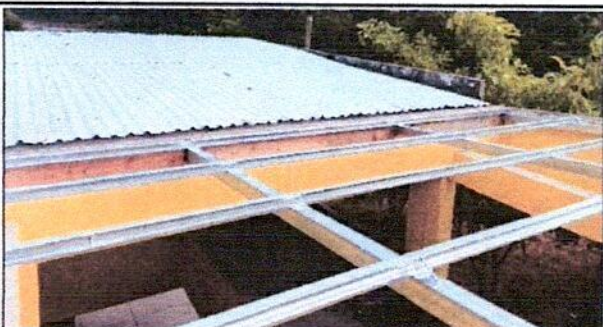
Foto 3: Después de haber realizado la demolición del techo de duralita, se procedió a hacer la instalación de los tubos y de las costaneras en módulo del salón y pasillo de Segundo Grado Sección E.
