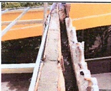
Foto 3: La reconstrucción los laterales de dichos canales, se hizo con cemento y arena, rellenando las ondulaciones donde se encontraba la durulita en los 2 módulos del salón de clases y pasillos de Segundo Grado
