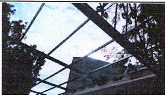
Foto 5: Instalación de tubos y costaneras en un módulo del Salón de Clases de área de carpintería.
