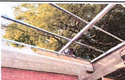
Foto 4: continuando con la instalacion de los tubos y costaneras, se revisa que todo este bien antes de la instalación de las láminas, un módulo del Salón de Clases de área de carpintería.
