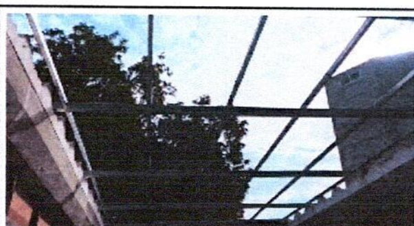
Foto 6: Instalación de tubos y costaneras en un módulo del Salón de Clases de área de carpintería.
