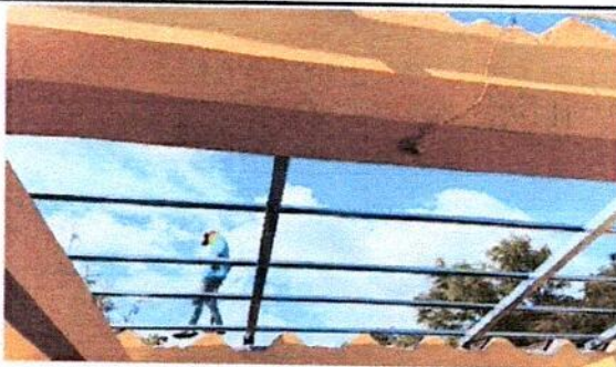
Foto 5: Instalación de tubos y costaneras en los dos módulos del Salón de Clases y Pasillo de Segundo Sección F, preparado para hacer la instalación de láminas
