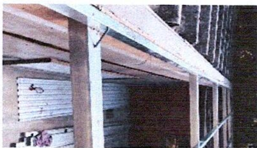
Foto 5: Terminado y esperando el secado de rellenado de las ondulaciones de los laterales de los canales de agua pluvial de un módulo del Salón de Clases de área de carpintería, queda listo para instalación de la estructura de techado
