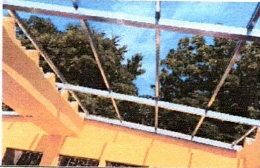
Foto 3: Después de haber realizado la demolición del techo de duralita, se procedió a hacer la instalación de los tubos y de las costaneras en los dos módulos del salón de clases y pasillo de Segundo Grado Sección F.
