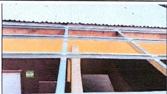
Foto 1: Después de haber realizado la demolición del techo de duralita, se procedió a hacer la instalación de los tubos y de las costaneras en módulo del salón y pasillo de Segundo Grado Sección E.
