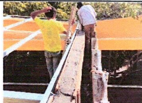
Foto 2: Se reconstruyó los laterales de los canales de agua pluvial
