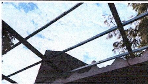
Foto 3: Después de haber realizado la demolición del techo de duralita, se procedió a hacer la instalación de los tubos y de las costaneras en un módulo del Salón de Clases de área de carpintería.
