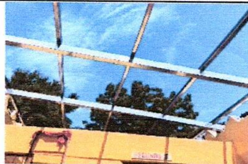
Foto 2: Después de haber realizado la demolición del techo de duralita, se procedió a hacer la instalación de los tubos y de las costaneras en los 2 módulos del salón de clases y pasillo de Segundo Grado Sección F.
