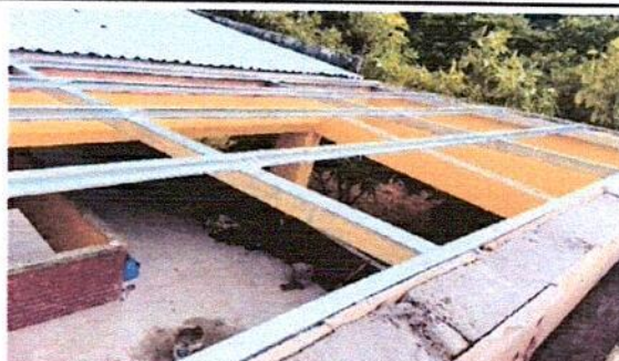
Foto 4: Terminado la acción de rellenado de las ondulaciones de los laterales de los canales de agua pluvial, queda listo para instalación de la estructura de techado, en módulo de salón y pasillo de Segundo Grado Sección E.
