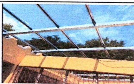
Foto 6: Instalación de tubos y costaneras en el módulo del Salón de Clases de Segundo Sección E, preparado para hacer la instalación de láminas
