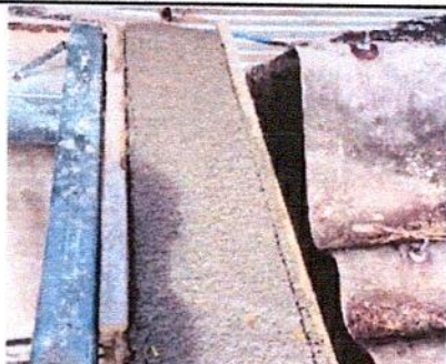
Foto 5: Terminado la acción de rellenado de las ondulaciones de los laterales de los canales de agua pluvial, queda listo para instalación de la estructura de techado, en módulo de salón y pasillo de Segundo Grado Sección E.
