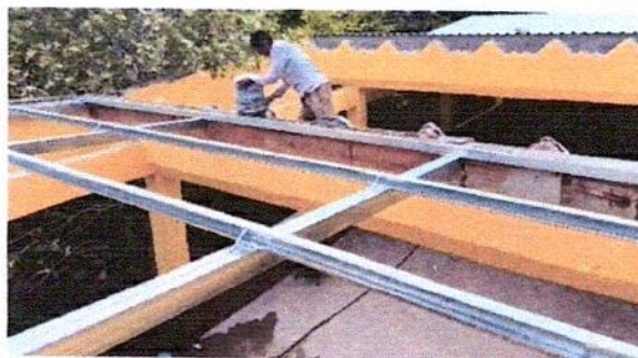
Foto 2: Se reconstruyó los laterales de los canales de agua pluvial de un módulo y pasillo de Segundo Grado Sección E
