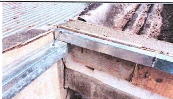
Foto 6: Terminado y Esperando el secado del rellenado de los laterales de los canales de agua pluvial, un módulo del Salón de Clases de área de carpintería, para la instalación de láminas
