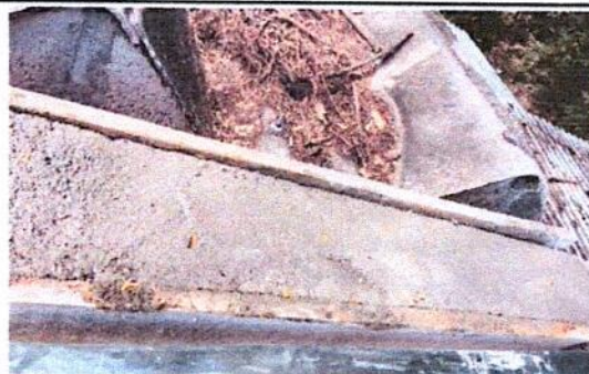
Foto 4: La acción de rellenado de las ondulaciones se hizo todos los canales de un módulo del Salón de Clases de área de carpintería.
