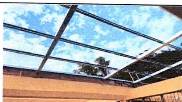
Foto 6: Instalación de tubos y costaneras en los dos módulos del Salón de Clases y Pasillo de Segundo Sección F, preparado para hacer la instalación de láminas
