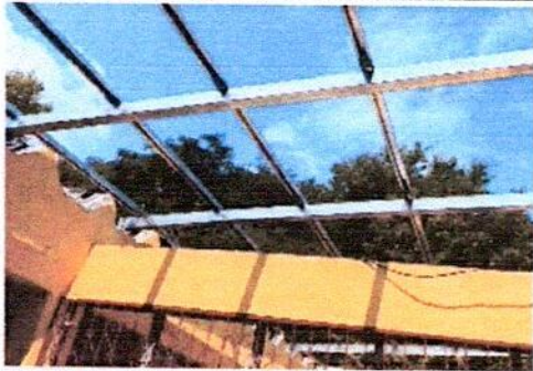
Foto 1: Después de haber realizado la demolición del techo de duralita, se procedió a hacer la instalación de los tubos y de las costaneras en el 2 módulos del salón clases y pasillo de Segundo Grado Sección F.
