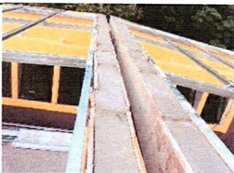
Foto 5: Terminado y esperando el secado de rellenado de las ondulaciones de los laterales de los canales de agua pluvial de los 2 módulos del salón de clases y pasillo de Segundo Grado Sección F, queda listo para instalación de la estructura de techado
