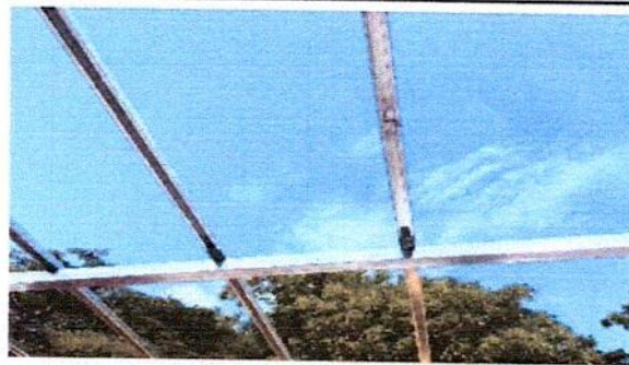
Foto 4: continuando con la instalación de los tubos y costaneras, se revisa que todo este bien antes de la instalación de las láminas.
