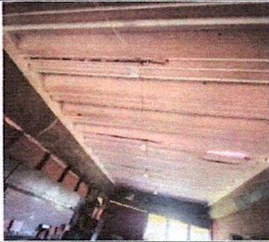
Foto 1: Aquí se está inspeccionando la modalidad de botar el techo de un módulo del salón de clases del área de carpintería.
