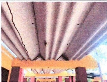
Foto 1: Aquí se esta inspeccionando la modalidad de botar el techo de un módulo que se encuentra enfrente del salón de conferencia
