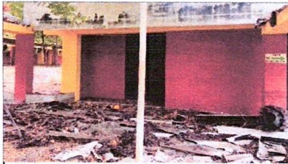
Foto 6: Se demolió la lámina duralita de un módulo que se encuentra enfrente del salón de conferencia
