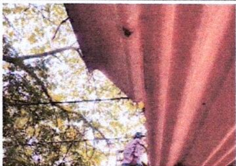
Foto 1: Aquí se esta inspeccionando la modalidad de botar el techo de un módulo que conduce al área de Segundo Grado Básico.
