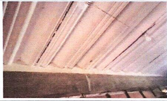
Foto 2: Se empezó a botar la Duralita del techo del un módulo del salón de clases del área de carpintería.
