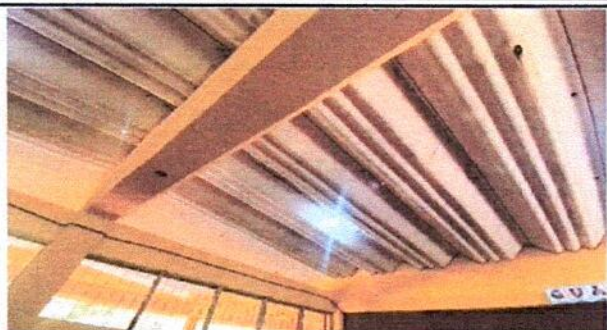
Foto 1: Aquí se esta inspeccionando la modalidad de botar el techo en los 2 módulos del salón de clases y pasillo, de Segundo Grado F.
