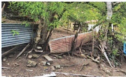
Foto 3: Sustitución de alambre espigado e implementación de malla galvanizada
