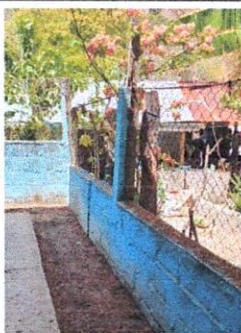
Foto 5: Sustitución de malla galvanizada
