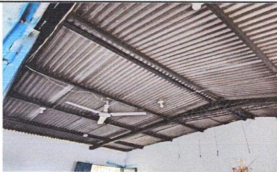
Foto 3: Instalación de Cielo Falso PVC en Aulas
