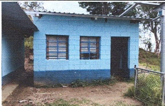
Foto 7: Sustitución de Chapa en Puerta en Dirección
