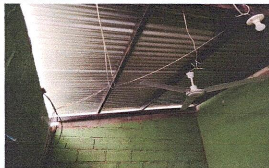
Foto 4: Instalación de Cielo Falso PVC en Aulas
