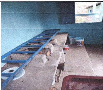
Foto 9: Sustitución de Estufa Rural Completa en Cocina
