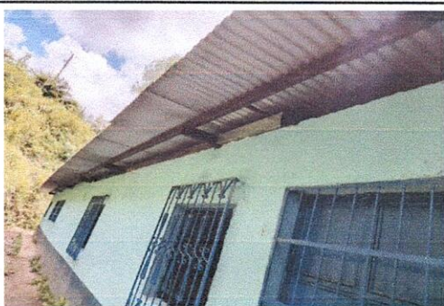
Foto 5: Cierre de Espacio entre Muro y Lámina (Entabicado) En Aula
