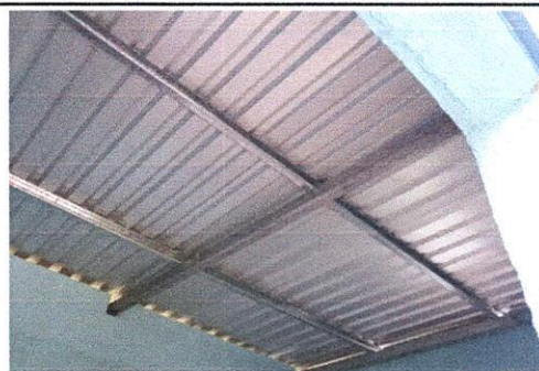
Foto 12: Instalación de Estructura de Metal por Lado Interno del Techo (para Evitar el ingreso de ladrones) en Cocina
