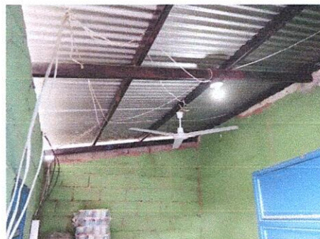
Foto 8: Instalación de Estructura de Metal por Lado Interno del Techo (para Evitar el Ingreso de Ladrones) en Bodega
