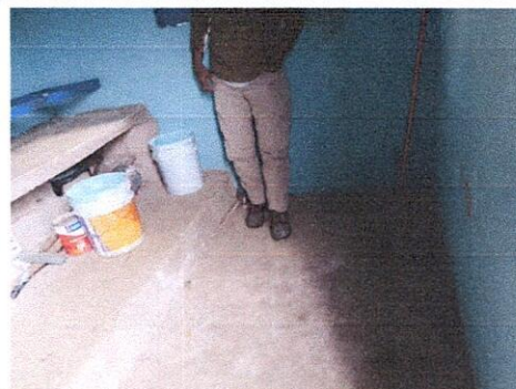
Foto 10 : Instalación de Piso Cerámico en Cocina
