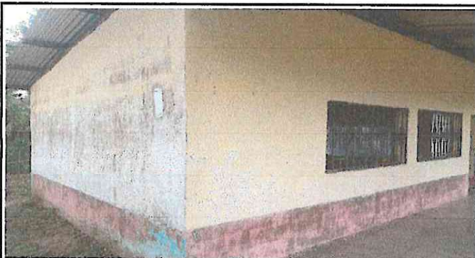
Foto 3: Pintura en Muros de Aulas
