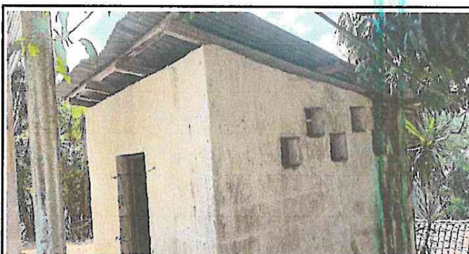
Foto 4: Sustitución de Lámina y Estructura de Soporte en Cocina
