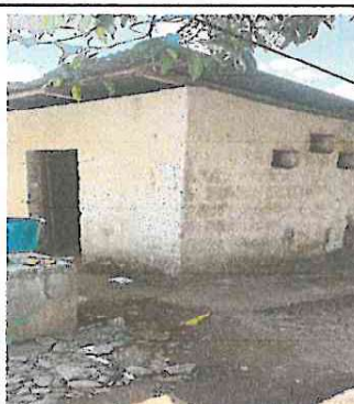
Foto 8: Instalación de Muros de Block en Cocina
