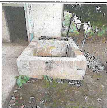
Foto 5: Sustitución de Pila de Concreto en Cocina a Construir en la Escuela
