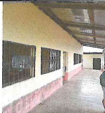
Foto 2: Sustitución de Estructura de Soporte en Aulas
