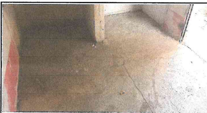
Foto 9: Sustrucción de Piso de Concreto por Piso Cerámico Mate en Cocina
