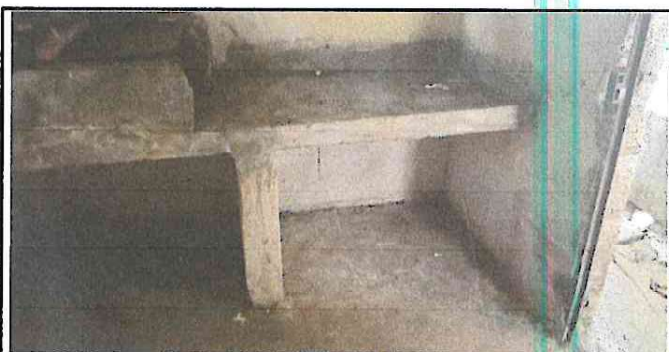
Foto 6: Sustitución de Mueble de Concreto en Cocina
