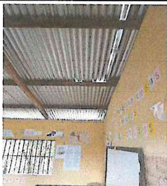
Foto1: Sustitución de Lámina en Aulas
