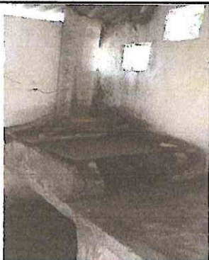
Foto 7: Sustrucción de Plancha y Tubos para Chimenea de Metal
