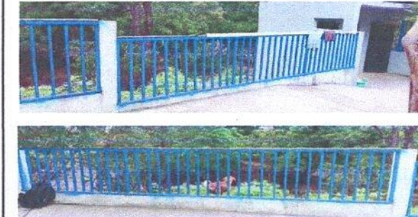
Foto 12: CONTINUIDAD DE REJAS DE METAL EN MURO PERIMETRAL / MANO DE OBRA PINTURA EN MURO PERIMETRAL INTERIOR Y EXTERIOR
