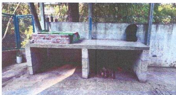
Foto 3: INSTALACIÓN DE AZULEJO EN MESONES
