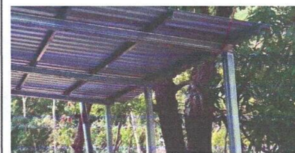
Foto 8: SUMINISTRO E INSTALACIÓN DE CANAL DE METAL EN COCINA
