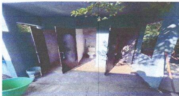
Foto 9: MANTENIMIENTO A PUERTAS DE BAÑOS
