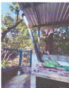
Foto 7: TUBO DE CEMENTO PARA CHIMINEA Y SUSTITUCIÓN DE PLANCHA DE COCINA RURAL
