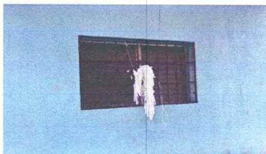
Foto 5: SUMINISTRO E INSTALACIÓN DE VENTANA DE PVC
