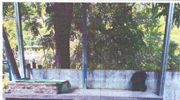
Foto 1: SELLADO DE VANO EN COCINA (INCLUYE CERNIDO)
