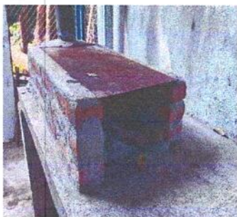
Foto 7: TUBO DE CEMENTO PARA CHIMINEA Y SUSTITUCIÓN DE PLANCHA DE COCINA RURAL
