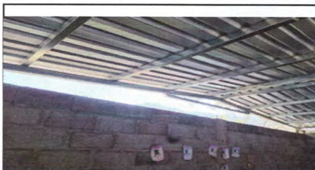
Foto 6: Instalacion de mosquitero en la parte abierta
