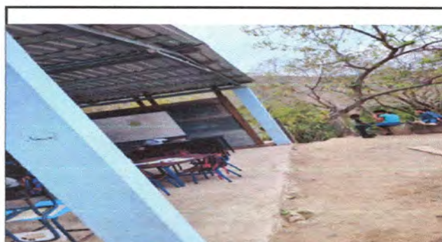
Foto 4: Levantado de paredes nuevas no existe nada
