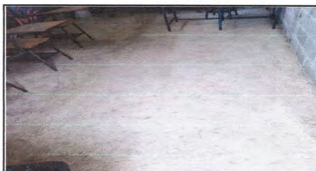
Foto 4: Instalación de piso cerámico
