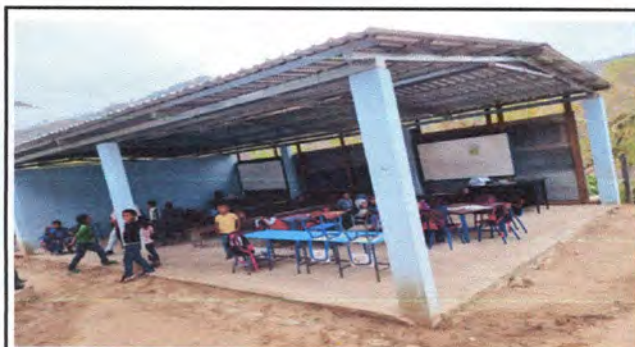
Foto 3: Levantado de paredes nuevas no existe nada
