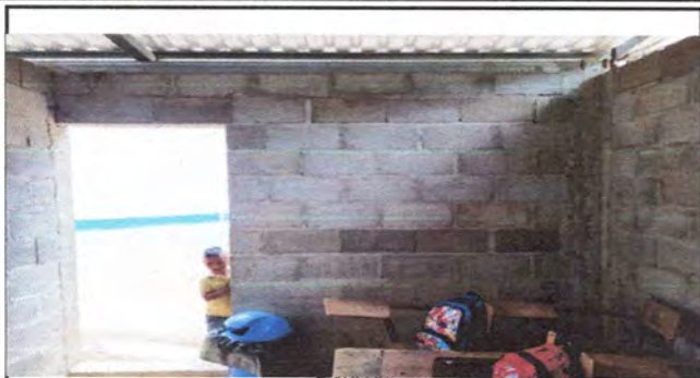
Foto1: Instalacion de puerta de metal y de puerta con cedazo
