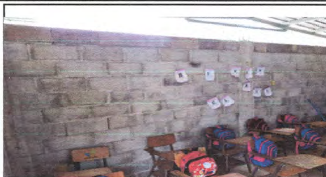
Foto 2: Aquí iría la pila y el top de concreto, la pared repellada.
