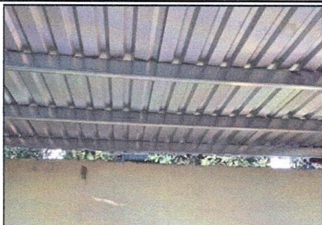
Foto 1: Suministro e instalación de CIELO RAZO PVC, DUELA BLANCA, Cerramiento de Contorno de Ambientes y Suministro y Aplicación de Pintura. Para EORM, ALDEA EL PINALITO.
