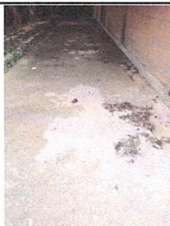
Foto 11: Reparación de Base y Suministro E Instalación de Piso Cerámico IP-IV. Para EORM. ALDEA EL PINALITO. (en Corredor de Parte Baja)
