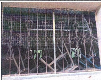
Foto 9: Sustitución de Balcones de Metal + Malla Galvanizada de Rombos de 1"x1" Calibre 12 (Parte Alta).
