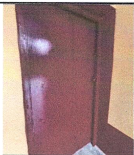
Foto 5: Sustitución de Puerta de Madera por Puerta Metálica. Para EORM, ALDEA EL PINALITO. (Parte Alta).
