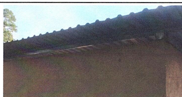
Foto 4: Suministro e instalación de CIELO RAZO PVC, DUELA BLANCA, Cerramiento de Contorno de Ambientes y Suministro y Aplicación de Pintura. Para EORM, ALDEA EL PINALITO. (Parte Alta).
