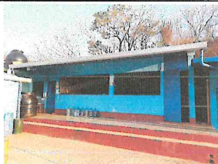
Foto 8: Mantenimiento en canales de agua pluvial, colocación de abrazaderas de bajadas de agua en mal estado, cambio de tubo de bajada de agua.
