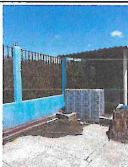
Foto 5: Fabricación e instalación de estructura para tanque
