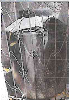
Foto 8: Sustitución de depósito de agua 1,000 lt
