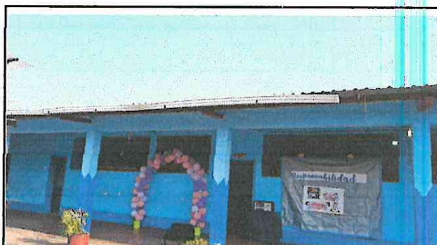
FOTO 4: Sustitución de Canal de PVC por canal de Metal
