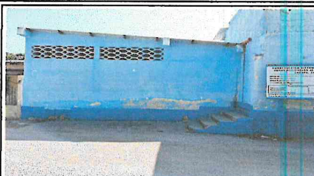
FOTO 2: Cernidos en Aulas, baños y cocina
