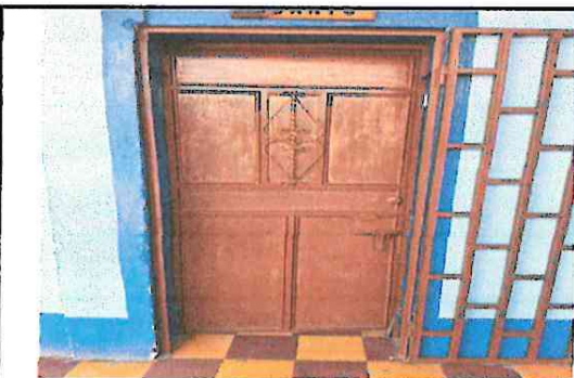
FOTO 3: Sustitución de Chapa por Chapa Yale
