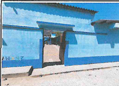
FOTO 9: Sustitución de Portón, Instalación de Rampa de Acceso e Intercomunicador en Entrada Principal
