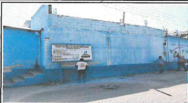
FOTO 1: Pintura de Muros Exteriores e Interiores en aulas
