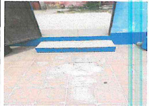
FOTO 8: Sustitución de piso de baldosa en patio
