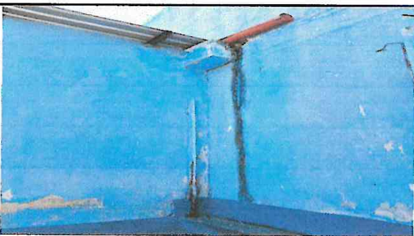
FOTO 5: Instalación de bajadas pluviales en canal
