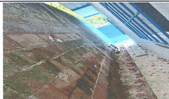
Foto 8: PINTURA EN MUROS INTERIORES Y EXTERIORES DE CORREDOR (se aplicará pintura después del cernido en la pared)
