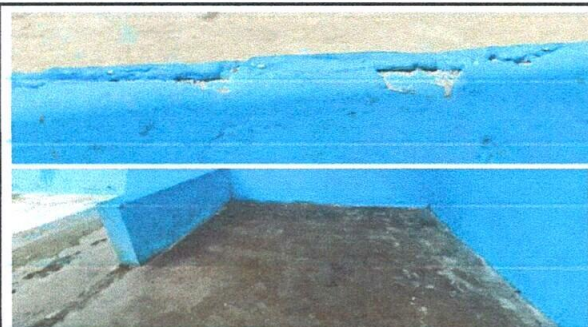
Foto 7: INSTALACIÓN DE AZULEJO EN CORREDOR
