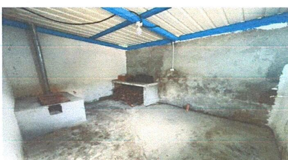
Foto 3: ELABORACIÓN DE LAVASTASTOS SUMINISTRO E INSTALACIÓN
