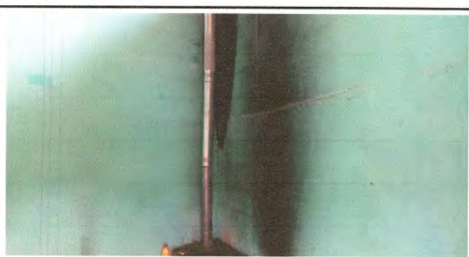
Foto 12: Repellos, Cernidos y Pintura en Cocina
