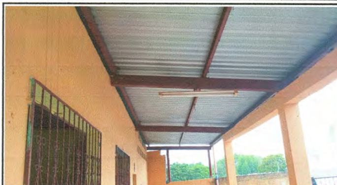
Foto 2: Electricidad en Aulas
