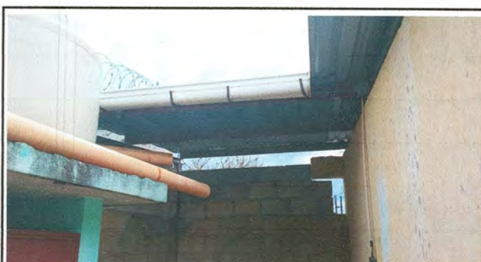
Foto 4: Sustitución de Canal de Aguas Pluviales en Baños
