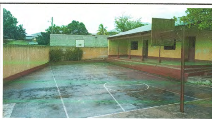
Foto 16: Pintura en Muros Interiores y Exteriores en Muro Perimetral
