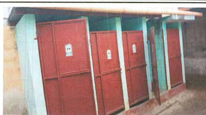
Foto 8: Mantenimiento de Puertas de Baños
