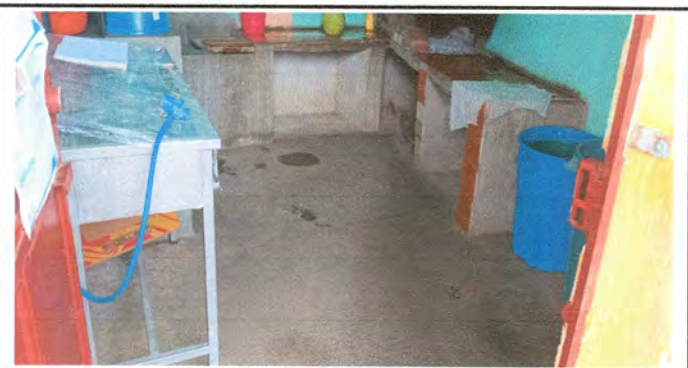
Foto 11: Instalación de Piso Cerámico Mate en Cocina
