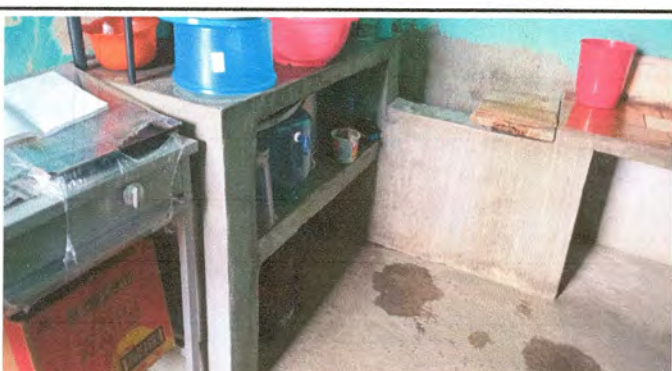
Foto 10: Sustitución de Mueble de Concreto con Azulejo en Cocina
