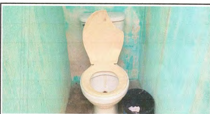
Foto 6: Sustitución de Inodoros en Baños
