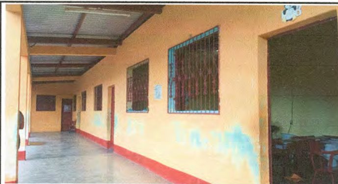
Foto 1: Electricidad en Aulas
