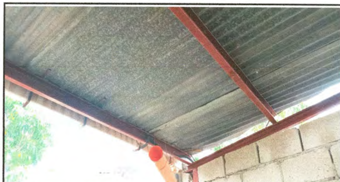
Foto 3: Sustitución de Lámina y Estructura de Soporte de Metal en Baños
