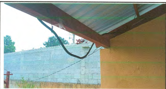
Foto 17: Repellos y Cernidos en Muro Perimetral
