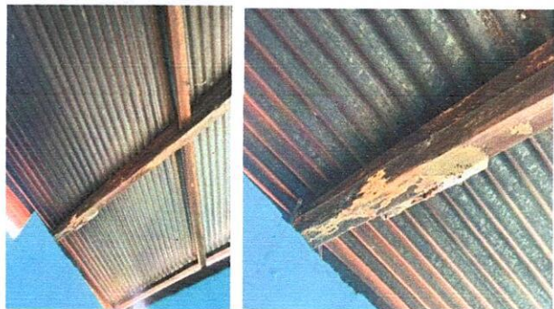
Foto1: SUSTITUCIÓN DE LÁMINA POR LÁMINA TROQUELADA ALUZINC CALIBRE 26 / SUSTITUCIÓN DE SOPORTE DE MADERA POR METAL EN COCINA
