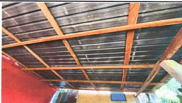
Foto 5: SUSTITUCIÓN DE LÁMINA POR LÁMINA TROQUELADA ALUZINC CALIBRE 26 / SUSTITUCIÓN DE SOPORTE DE MADERA POR METAL
