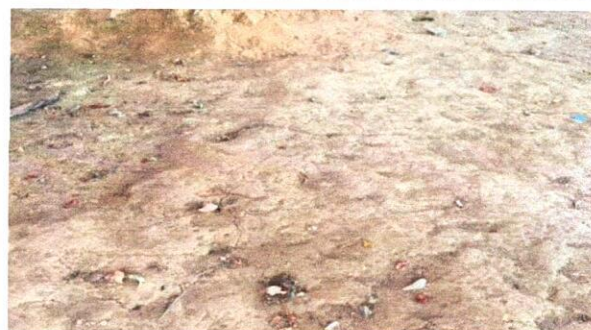
Foto 4: SUSTITUCIÓN DE PISO A PISO DE CEMENTO LIQUIDO EN COCINA
