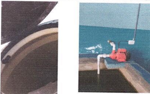
Foto 3: Sustitución de accesorios de depósito de agua y bombas de agua.
