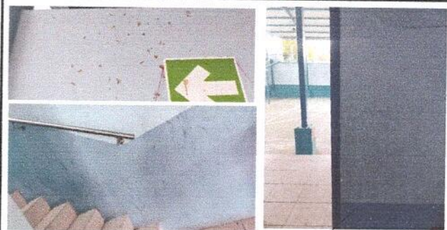
Foto 6: Pintura en paredes interiores y exteriores.
