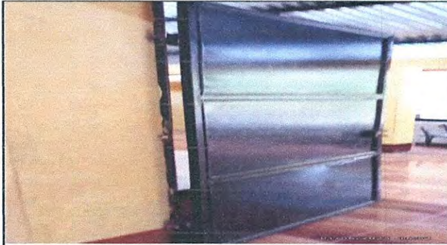
Foto 7: MANTENIMIENTO PUERTA DE METAL DIRECCIÓN (LIJADO, APLICACIÓN DE PINTURA)
