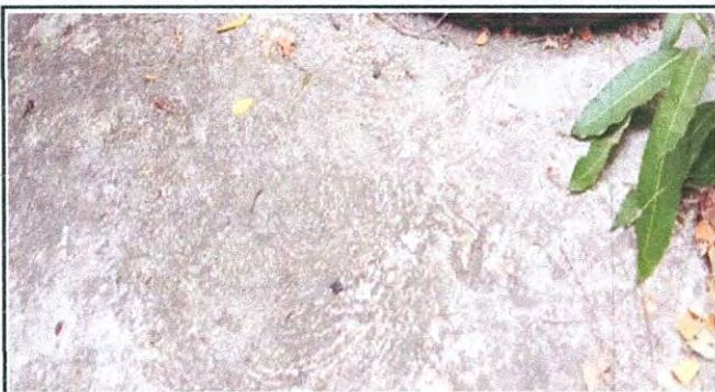
Foto 19: IMPERMEABILIZACIÓN EN LOSA DE TERRAZA DE SANITARIOS
