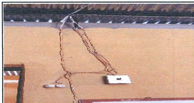
Foto 23: REPARACION DE SISTEMA ELECTRICO DIRECCION
