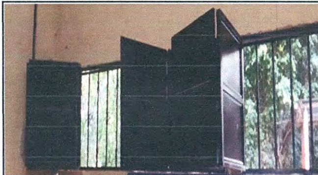
Foto 9: VENTANA: SUSTITUCIÓN DE VENTANA DE METAL POR VENTANA PVC, AULA DE PRIMARIA 1
