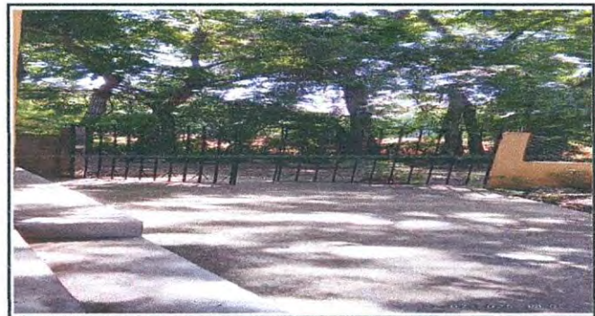
Foto 12: REPARACION DE CUNETA DE CONCRETO EN TORTA DE CEMENTO EN INGRESO.
