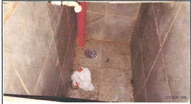
Foto 2: REPARACIÓN DE TUBERÍA DE DESAGÜE EN PILA, AZULEJO EN FONDO DE PILA DE COSINA
