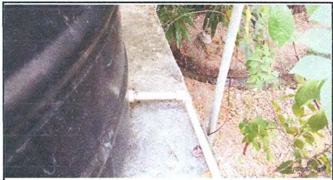
Foto 16: SUSTITUCION DE ACCESORIOS DE DEPOSITO DE AGUA
