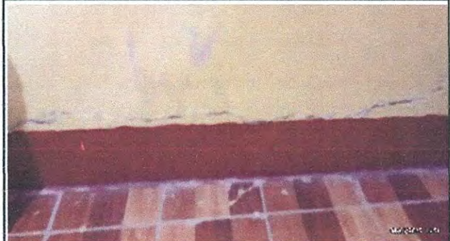
Foto 14: REPELLO, CERNIDO, PINTURA EN AULA DE PRIARIA 2
