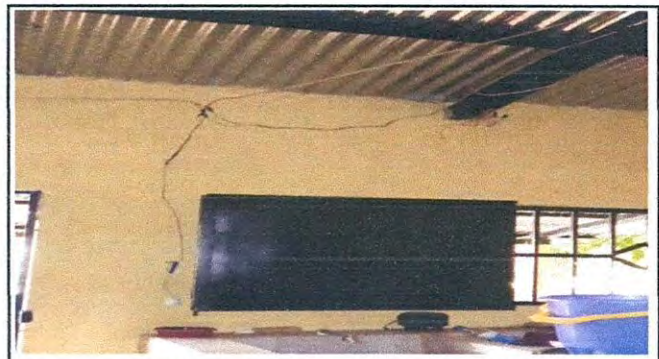
Foto 4: REAPARACION E INSTALACION DE CABLEADO ELECTRICO EN COSINA
