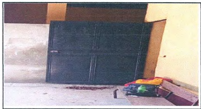
Foto 6: SUSTITUCIÓN DE PUERTA EN PRIMARIA 1
