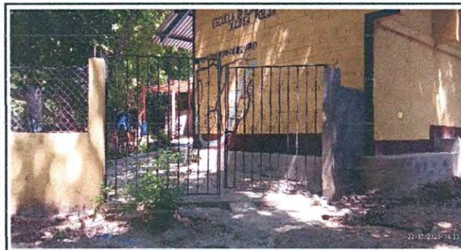
Foto 11: SUSTITUCION DE PORTON DE METAL DE INGRESO
