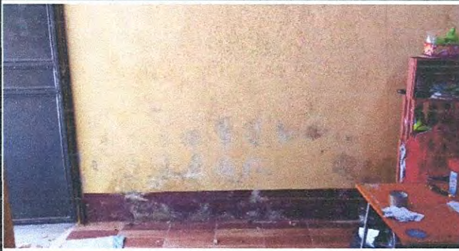
Foto 13: REPELLO, CERNIDO Y PINTURA EN MURO AULA PRIMARIA 1
