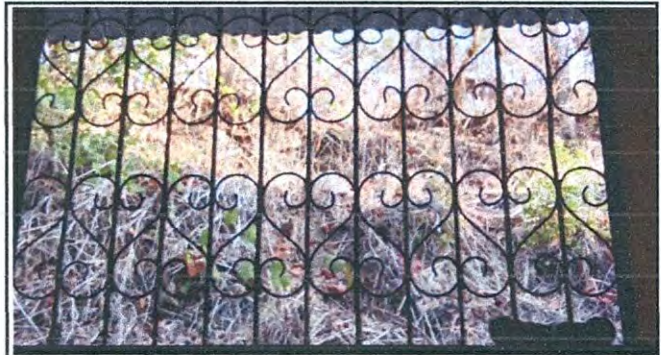
Foto 8: VENTANA: MANTENIMIENTO DE BALCÓN DE METAL (PINTURA) PRIMARIA 2, DIRECCIÓN,
