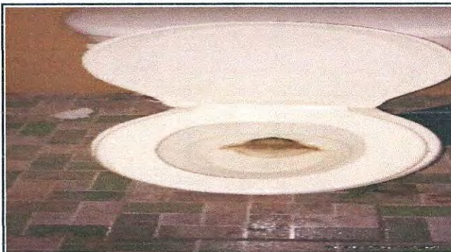
Foto 20: SUSTITUCION DE INODOROS
