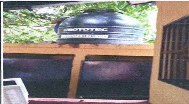
Foto 15: SUSTITUCION DE DEPOSITO DE AGUA
