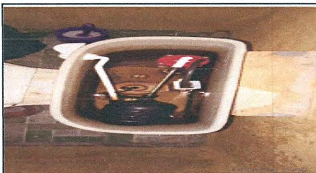
Foto 21: SUSTITUCION DE ACCESORIOS DE INODOROS
