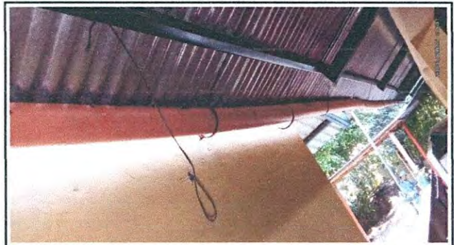
Foto 10: SUSTITUCION DE CANALES DE PVC POR CANAL DE METAL Y SUS BAJANTES. EN CORREDORES
