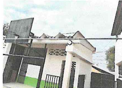
Foto 4: Desinstalación de techo duralita y Sustitución por lamina COLOR Alum calibre 26
