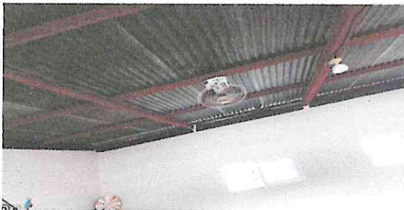
Foto 3: Mantenimiento a estructura de soporte de metal
