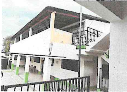
Foto1: Desinstalación de Techo
