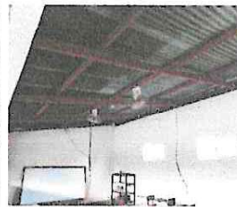
Foto 2: Sustitución de lamina por lamina COLORAlum y Suministro e Instalación de Cielo Falso
