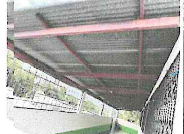
Foto 2: Sustitución de lamina por lamina COLORAlum y Suministro e Instalación de Cielo Falso
