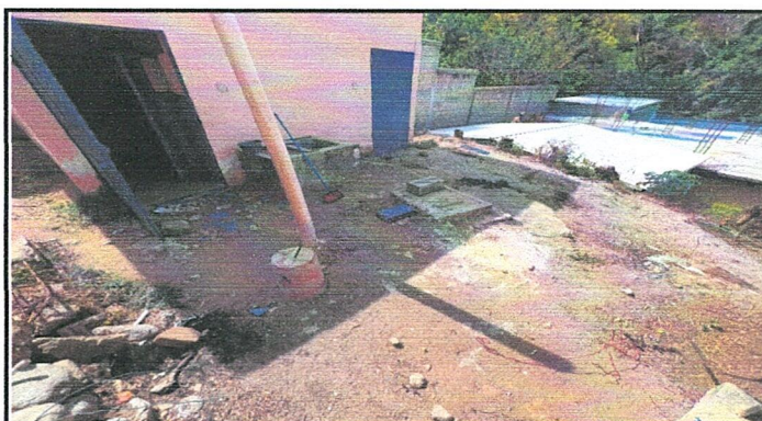
Fundicion de piso de cemento en ingreso a sanitarios
