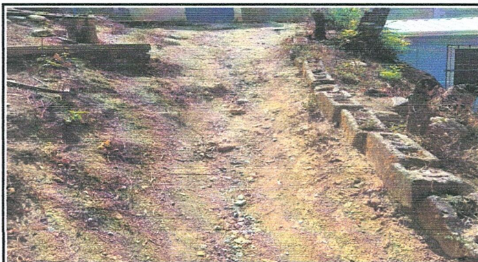
fabricacion e instalacion de barandas tipo pasamanos cuando esten las gradas
