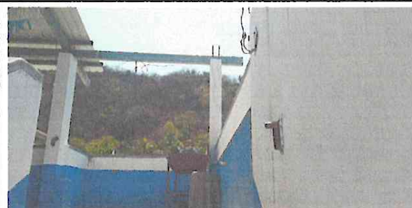
Foto 4: Reparación de muro de block (instalación de hiladas de block)
