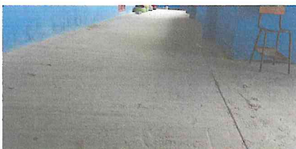
Foto 6: Reparación y sustitución de piso de concreto por piso ceramico
