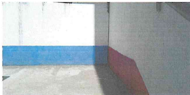
Foto 2: Reparación del muro y las columnas para el segundo nivel
