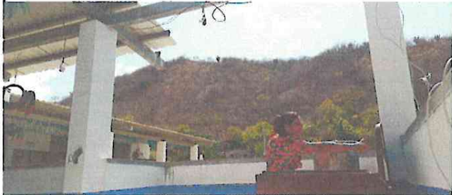
Foto 3: Sustrucción de lamina y estructura de soporte de las gradass para la cocina
