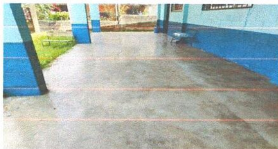
Foto 4: SUSTITUCIÓN PISO DE CEMENTO A PISO CERÁMICO ANTIDESLIZANTE CORREDOR
