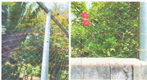
Foto 9: SUSTITUCIÓN DE MALLA GALVANIZADA
