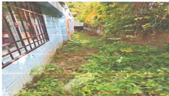
Foto 2: ELABORACIÓN DE CUNETA ATRÁS DE AULAS PARA DESVÍO DE AGUA PLUVIAL (Se realizará para que el agua no se siga filtrando en la pared ya que esta ingresando el agua a las aulas)
