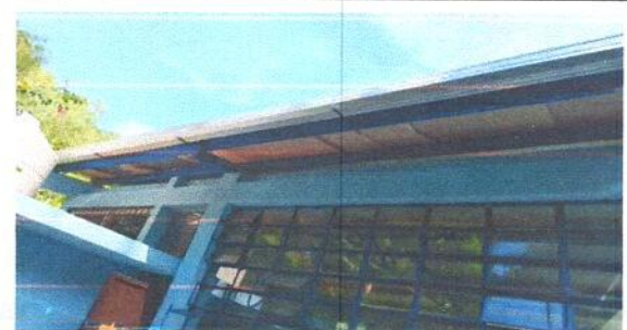
Foto 5: INSTALACIÓN DE BAJADAS DE AGUA PLUVIAL EN CANAL
