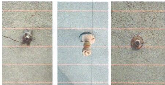
Foto7: SUSTITUCIÓN DE LAMPARAS LED DE 75 WATTS / SUSTITUCIÓN DE PLAFONERAS / SUSTITUCIÓN DE CABLE ELÉCTRICO
