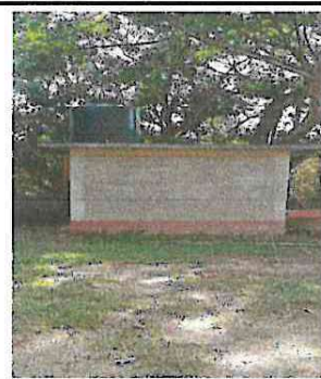
Foto 6: Sustrucción de Depósito de Agua de 1100 lts
