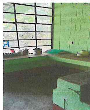
Foto 10: Instalación de Azulejo en Mueble de Concreto
