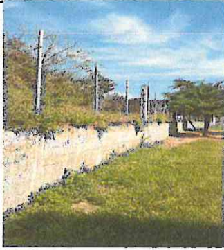
Foto 1: Sustrucción de malla por cuadros de 2.80 mts por 2 mts de Tubo Proceso de 1 pulgada y malla de 2 pulgadas de diámetro
