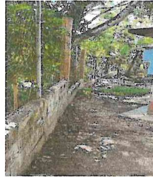
Foto 2: Sustrucción de malla por cuadros de 2.80 mts por 2 mts de Tubo Proceso de 1 pulgada y malla de 2 pulgadas de diámetro
