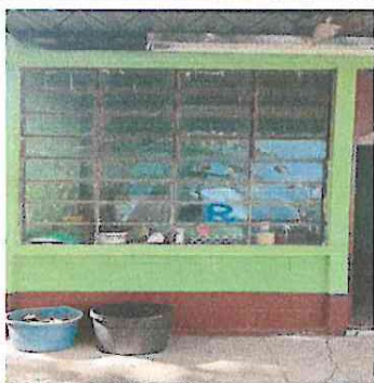
Foto 9: Sustrucción de Balcón e Instalación de Ventana de PVC
