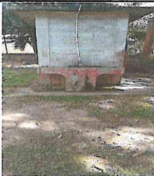
Foto 5: Sustrucción de Pila de Concreto de 2 Lavaderos por una de Concreto de 1 Lavadero a Construirse en la Escuela
