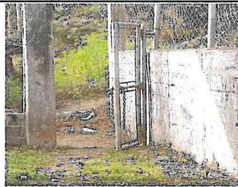
Foto 4: Mantenimiento de Puerta de Salida de Emergencia
