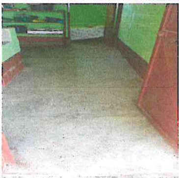
Foto 7: Sustrucción de Piso de Concreto por Piso Cerámico
