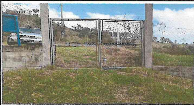
Foto 3: Mantenimiento de Portón de Entrada Principal
