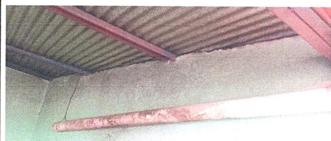
Foto 3: Suministro e instalación de block ( subir 2 hiladas) en cocina.
