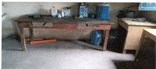
Foto 7: Instalación de piso cerámico mate en cocina.
