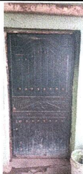
Foto 11: Mantenimiento de puerta en baños.
