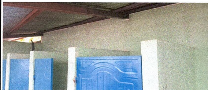
Foto 13: Pintura de muros en baños.
