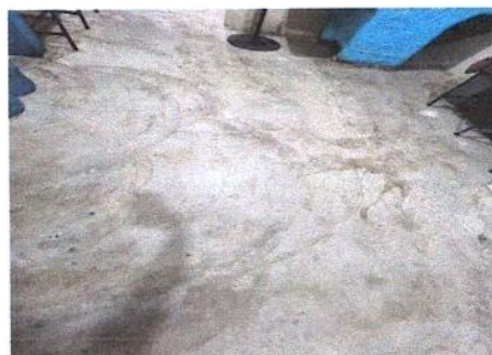
Foto 6: PISO COCINA ( Sustitución con piso antideslizante cerámico )
