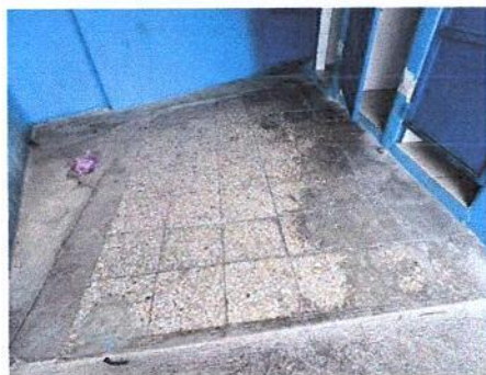
Foto 6: SUSTITUCIÓN DE PISO BAÑO DE NIÑOS
