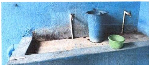
Foto 5: GRIFOS DE BAÑOS ( Trabajos a realizar )
