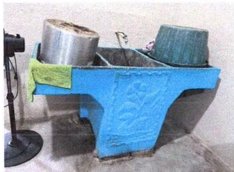
Foto1: PILA EN COCINA ( Se sustituirá por dos pilas de concreto fundidas )
