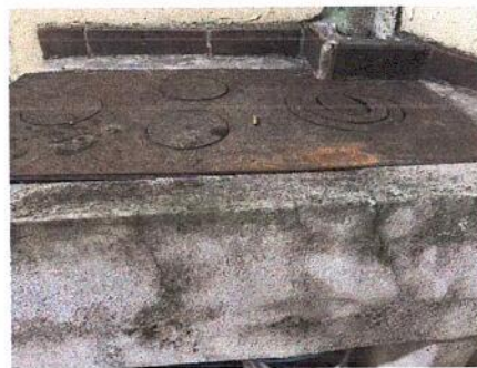
Foto 4: SUSTITUCION DE ESTUFA RURAL POR CHIMENEA Y PALNCHA DE METAL
