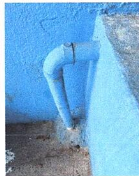
Foto 2: SUSTITUCION DE TUBERÍA DE AGUA POTABLE
