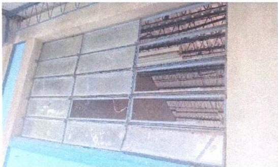
Foto 1: VIDRIOS VENTANA ( se instalarán vidrios a todas las ventanas y se sustituirán las que están quebradas )
