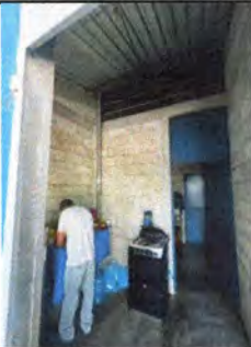
Foto 5: Reparación de Cocina: Remoción de Pared Intermedia, Suministro de Lavaplatos, Gabinetes, Sistema Eléctrico y Reubicación para Gabinetes Aéreos. EODP ALDEA SANTA ROSALIA, ZACAPA, ZACAPA.
