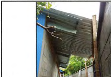
Foto 9: Reparación de Bodega: Sustitución de Madera por Estructura de Metal, Costaneras, Lámina Troquelada Calibre 26 Legítima, Canal Metálico, Cerramiento de Block, Balcones Metálicos, Reinstalación de Puerta Metálica. EODP ALDEA SANTA ROSALIA, ZACAPA, ZACAPA.
