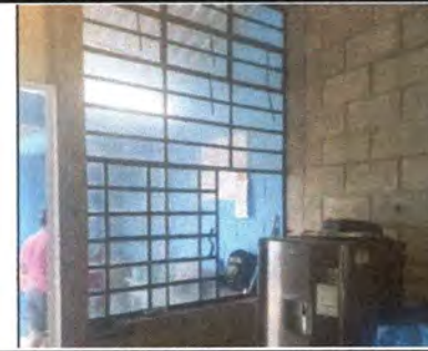
Foto 6: Reparación de Cocina: Sustitución de Ventana de PVC + Vidrio de 5MM. Con Ventanilla para dar Alimentación a los Estudiantes. EODP ALDEA SANTA ROSALIA, ZACAPA, ZACAPA.
