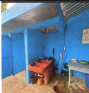
Foto 3: Reparación de Servicios Sanitarios: Pañuelos, Impermeabilización de Losa, Suministro de Piso y Azulejos; Desmontaje de Pila Plástica y Suministro de Lavamanos de Concreto. EODP ALDEA SANTA ROSALIA, ZACAPA, ZACAPA.
