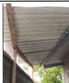
Foto 10: Reparación de Bodega: Sustitución de Madera por Estructura de Metal, Costaneras, Lámina Troquelada Calibre 26 Legítima, Canal Metálico, Cerramiento de Block, Balcones Metálicos, Reinstalación de Puerta Metálica. EODP ALDEA SANTA ROSALIA, ZACAPA, ZACAPA.
