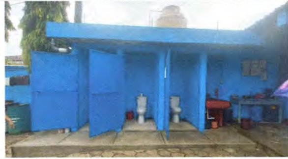
Foto 2: Reparación de Servicios Sanitarios: Pañuelos, Impermeabilización de Losa, Suministro de Piso y Azulejos. EODP ALDEA SANTA ROSALIA, ZACAPA, ZACAPA.
