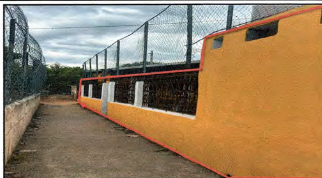
Numeral 8.1 Pintura de Muro Interior y Exterior (Línea Refleja área)
