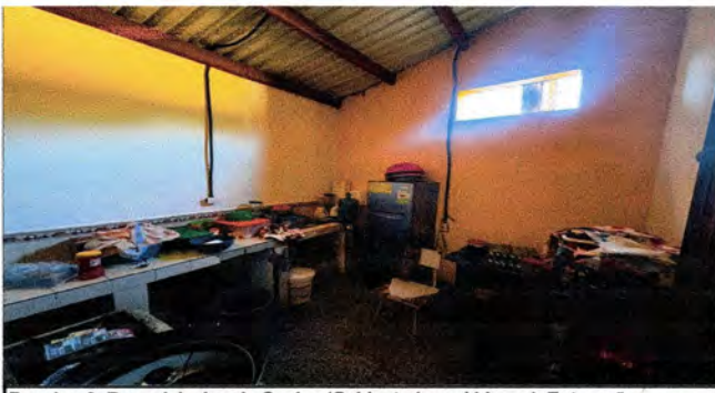
Renglon 6: Remodelacion de Cocina (Gabinete (pared blanca), Entrepaños y puertas pvc P/ Gabinete existente, Azulejo quebrados y estufa, Ventilador aereo, Cableado electrico y tubo ducto P/Nuevas conexiones de tomas de corriente)
