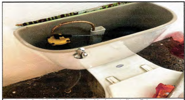
Renglon 7: Servicios Sanitarios (Cambio de contrallave, Tubo avasto y Accesorios tanque)
