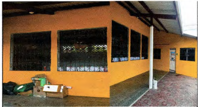
Renglon 5: Suministro e Instalacion de Ventanas de PVC de buena calidad. Total 19 mts (8 Ventanas de medida Variable)
