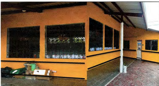
Numeral 8.2 Aplicación de Pintura de Zocalo paredes exteriores de aulas 0.60m de alto (Línea negra hace referencia al área de zocalo)
