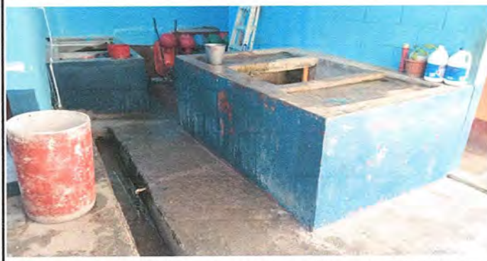
Foto 20: Instalación de Azulejo en Pilas de Baños
