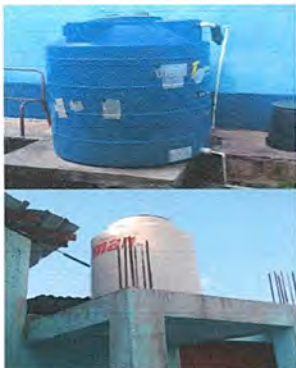
Foto 19: Sustitución de 2 Cisternas de Agua de 1,100 Litros y Base de Metal en Baños
