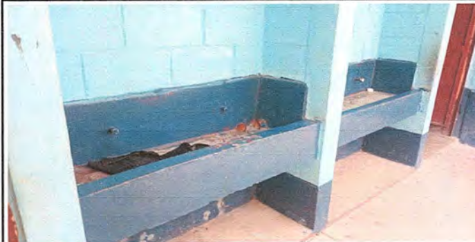
Foto 14: Instalación de Azulejo en Lavamanos en Baños
