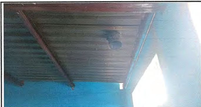
Foto 17: Sustrucción de Lámina Troquelada Dañada por Lámina Troquelada
