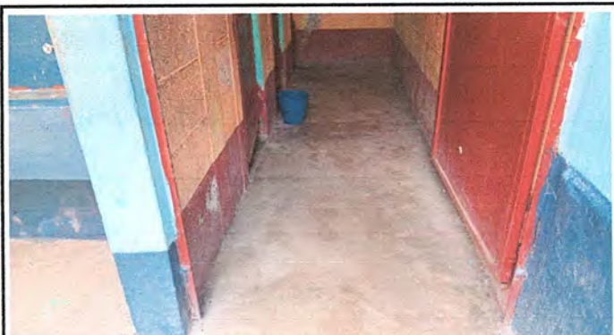
Foto 9: Sustitución de Piso de Concreto en Baños
