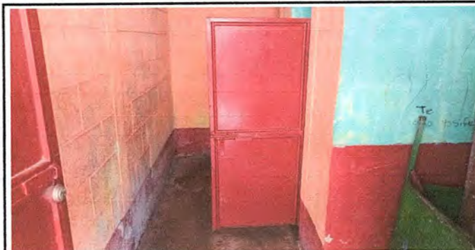
Foto 11: Sustitución de Puertas de Metal en Baños
