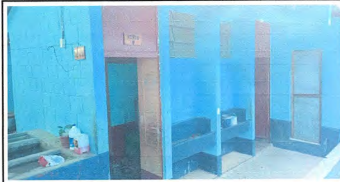
Foto 16: Pintura en Muros de Baños
