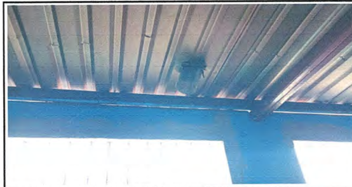
Foto 18: Sustrucción de Lámina Troquelada Dañada por Lámina Troquelada
