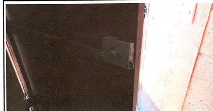
Foto 12: Sustitución de Chapas en Puertas de Baños
