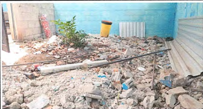
Foto 1: Nivelación y Compactación para Fundición de Piso en Aulas
