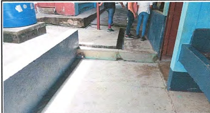
Foto 8: Sustitución de Piso de Concreto en Baños
