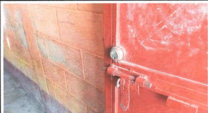
Foto 13: Sustrucción de Chapas en Puertas de Baños
