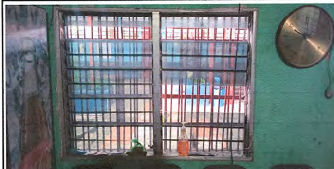
Foto 22: Instalación de Ventanas PVC en Aulas
