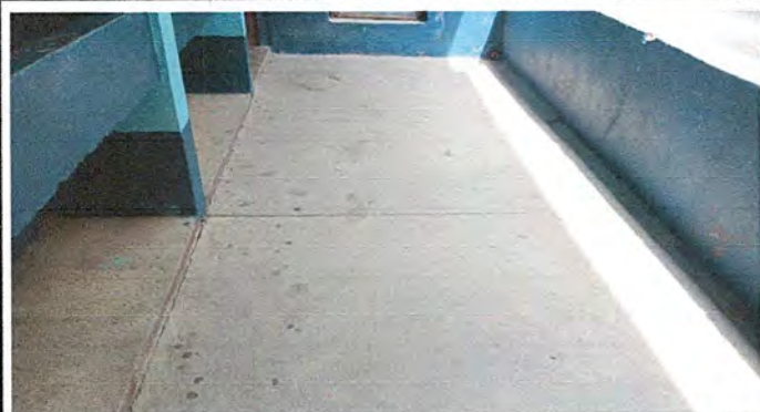
Foto 7: Instalación de Piso Cerámico Mate
