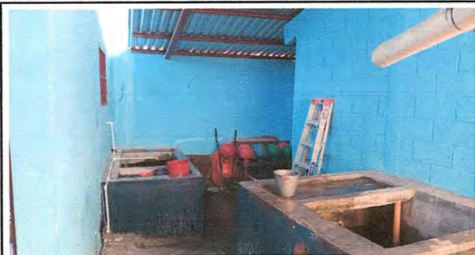
Foto 15: Pintura en Muros de Baños
