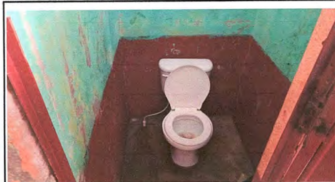
Foto 10: Sustitución de Inodoros en Baños
