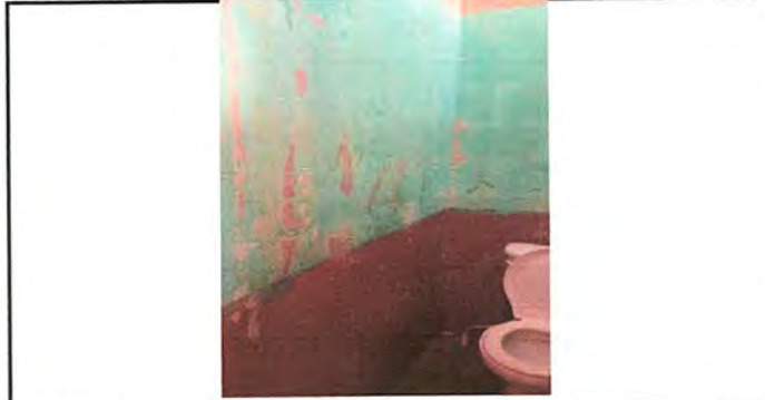
Foto 6: Instalación de Azulejo en Baños
