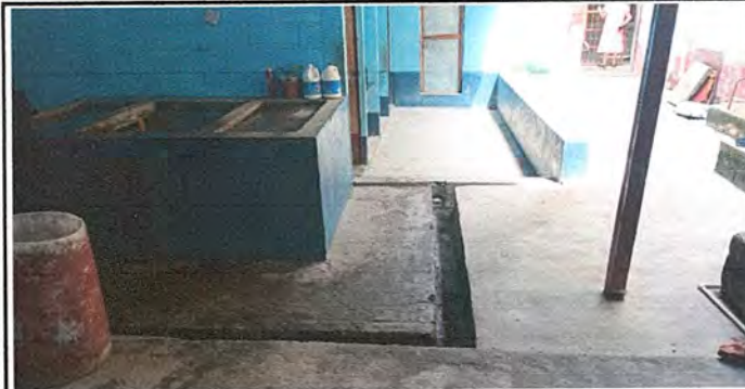
Foto 4: Nivelación para Piso de Concreto en Baños
