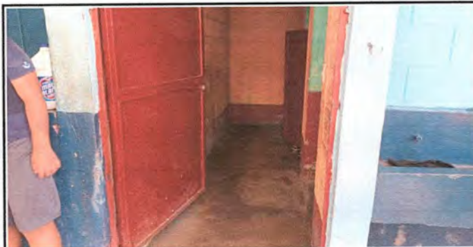
Foto 5: Instalación de Azulejo en Baños
