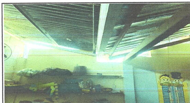
SELLADO DE GRIETAS Y ESPACIOS EN PAREDES
