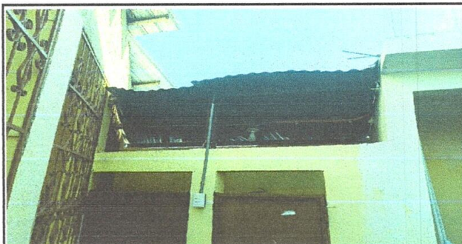
SUSTITUCION DE ESTRUCTURA DE METAL Y LAMINA TROQUELADA DE ALUZINC CALIBRE 26 EN AREA DE BAÑOS
