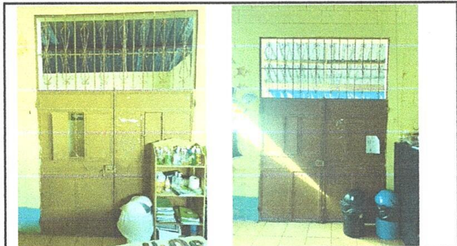
MANTENIMIENTO A PORTONES DE INGRESO A AULAS DE 2X3 M2 (REPARACION, LIJADO Y PINTADO).
