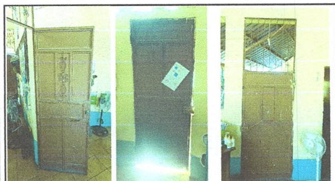
MANTENIMIENTO A PUERTAS DE METAL (REPARACION, LIJADO Y PINTADO), Y INSTALACION DE CHAPAS YALE
