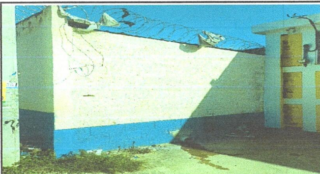
SUMINISTRO E INSTALACION DE PINTURA DE BUENA CALIDAD EN AREA EXTERIOR DE CALLE
