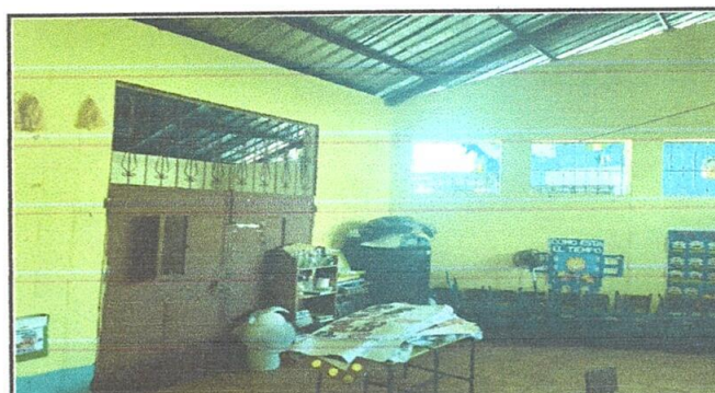
SUMINISTRO E INSTALACION DE PINTURA DE BUENA CALIDAD EN INTERIOR DE AULAS
