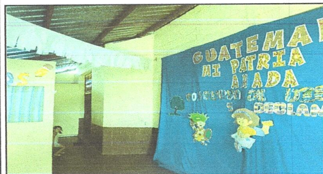
SUMINISTRO E INSTALACION DE PINTURA DE BUENA CALIDAD EN AREA EXTERIOR DE AULAS
