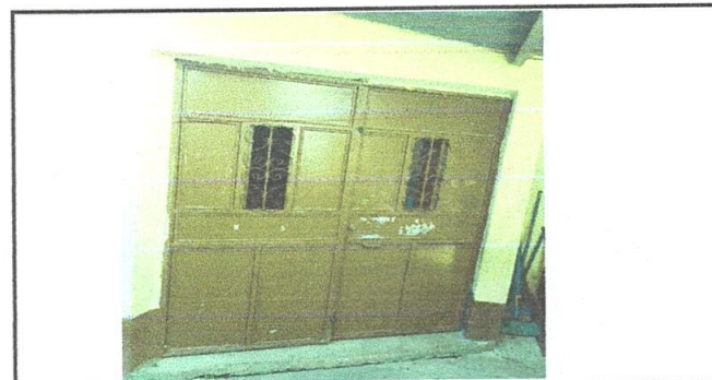
MANTENIMIENTO A PORTONES DE INGRESO A AULAS DE 2X2 M2 (REPARACION, LIJADO Y PINTADO).
