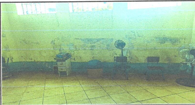
SUMINISTRO E INSTALACION DE REPELLO, CERNIDO Y IMPERMEABILIZANTE EN PAREDES QUE HAY MUCHA HUMEDAD PORQUE EN A PARTE DE ATRÁS DE LA PARED HAY UN JARDIN LO CUALL ESTA AFECTANDO QUE LA PARED TENGA HONGO Y MUCHA HUMEDAD.
