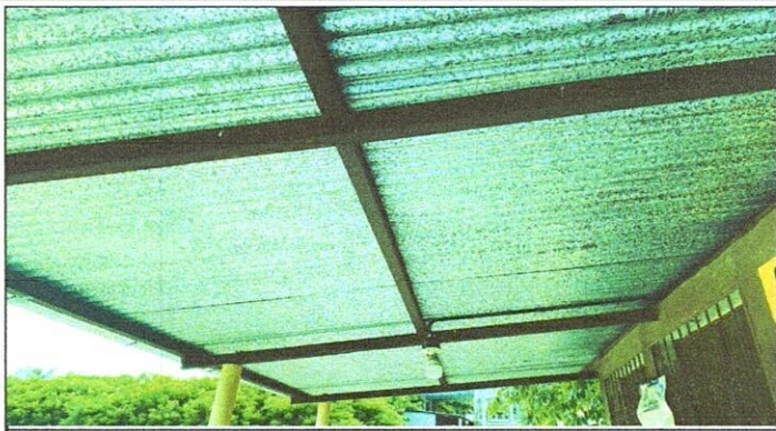
Foto 7: Lámina que se encuentra en el corredor de la cocina, la cual será quitada y trasladada para la estructura que se realizará sobre el módulo de baños.
