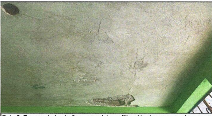
Foto 5: Terraza de los baños con grietas y filtración de agua, por lo que, se hace necesario colocarle techo de lámina para evitar se siga dañando.
