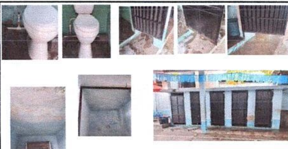
Foto 3: Instalación de tubería de PVC, para aguas negras y conducción de agua a sanitarios, mantenimiento de puertas, instalación de unidades de fuerza, luz y focos ahorradores.
