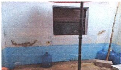
Foto 3: Reparación de repello en muros (incluye tratamiento antihongos)
