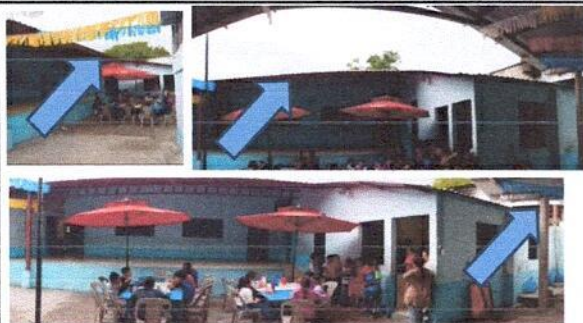
Foto1: sustitución de estructura metálica y techo de lámina, instalación de canales y bajadas pluviales
