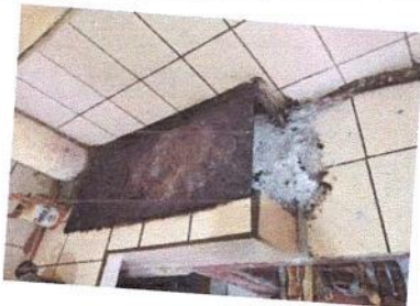
Foto 1: Sustrucción de hornilla ahorradora de leña
