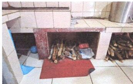
Foto 2: Reparación de azulejos
