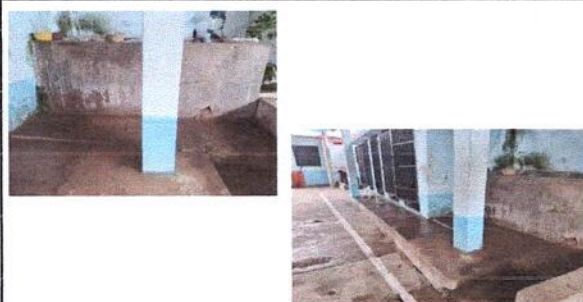
Foto 5: Reparación de pila principal, Instalación de piso antideslizante
