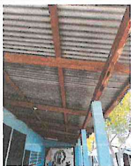
Foto1: Sustitucion de soporte de madera por metal ✓
