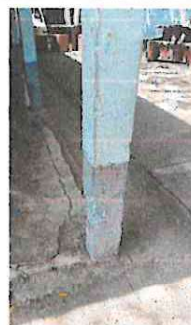
Foto 4: Mantenimiento de columnas ✓
