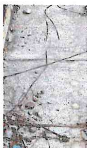
Foto 5: Elaboracion de torta de cemento en patio ✓
