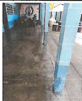
Foto 3: Sustitucion de piso de cemento por piso ceramico ✓
