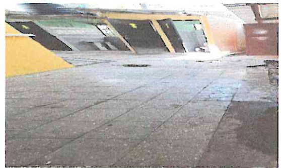
1.3 Sustitucion de piso por piso de cemento liquido
