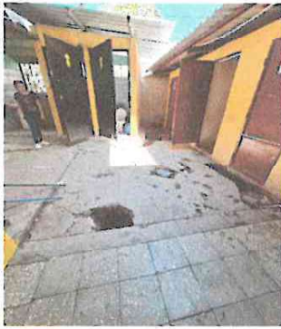
1.1 Relleno de fosa en area de patio
