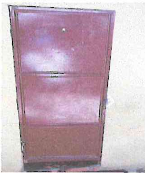
2.1 Sustitucion de puerta de metal en baños de 1.60x0.80
