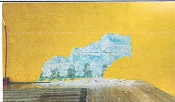
Foto 12: Reparación de Cernidos mal aplicados (Se va a picar y aplicar nuevamente de manera correcta) 7.1
