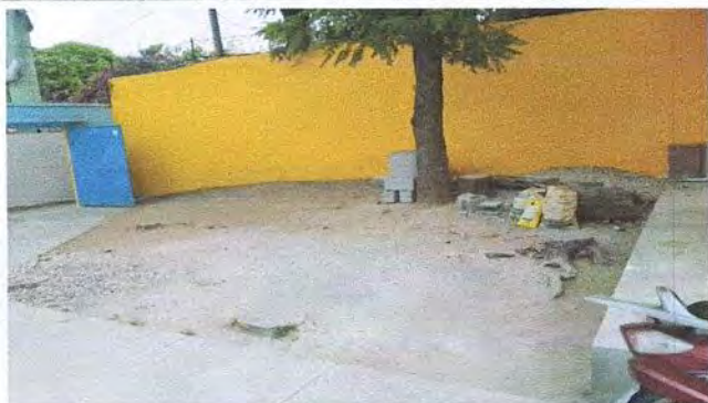
Foto 19: Renovacion de patio del Area frontal (nivelacion extracion de arboles y encementado)
