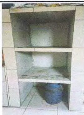
Foto 21: Puertas de pvc y colocacion de azulejo para gabinete de cocina 4.5
