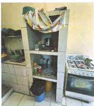
Foto 9: Puertas de PVC abatibles para alacena de concreto (0.42M2) 4.5
