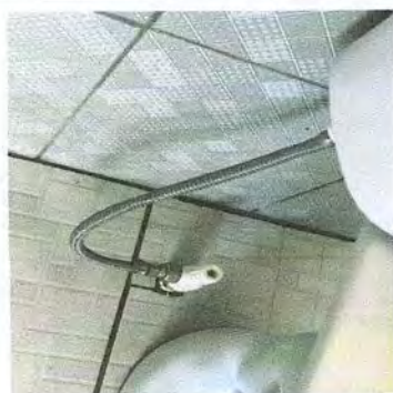
Foto 3: Sustitucion de llaves de paso y mangueras en mal estado BAÑO 2.1
