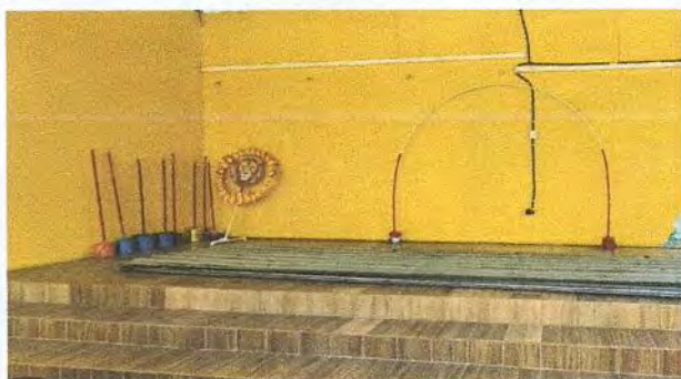
Foto 17: colocacion de socalo para escenario 7.2
