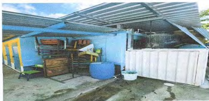
Foto 4: Suministro e Instalacion de cableado electrico #8 cubierto con flexitubo para bomba con flipon de 20 amp, Suministro e Instalacion de Bomba de 1 HP con Presurizador Y Conexión de rotoplas hacia tubería (con accesorios) BAÑO 2.3 Y 2.4
