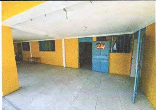
Foto1: SUMINISTRO E INSTALACION DE VENTANAS DE PVC SALON 1.3
