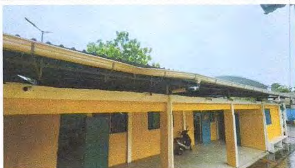
Foto 15: Renovacion de Bajada de agua e instalacion de tuveria hacia drenaje 5.1
