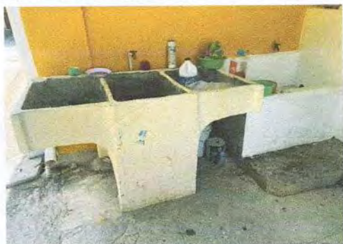
Foto 5: Fabricacion de Pila de 1 lavadera con tanque de 1.2M3, Sustitucion de lavamanos (Demoler de concreto e instalar de ceramica) Y Cambio de 1 sifon 2.5 Y 2.6
