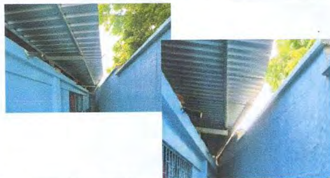
Foto 6: Sustitucion de canal de pvc por canal de lamina aluzinc con bajada pluvial y pescantes (accesorios) 15 ML 3.1
