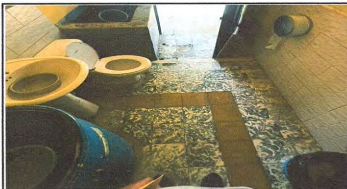
Sustitucion de piso por piso ceramico antideslizante, modificacion de puerta y pintura de la misma, sustitucion de accesorios de tanque y llave de lavamanos
