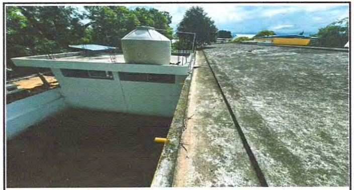
El area para la fundicion de sobre nivel de losa de techo cuenta con caídas de agua hacia los laterales, esta es el area donde se fundira el sobrenivel, y asi mismo se le aplicara impermeabilizante.
