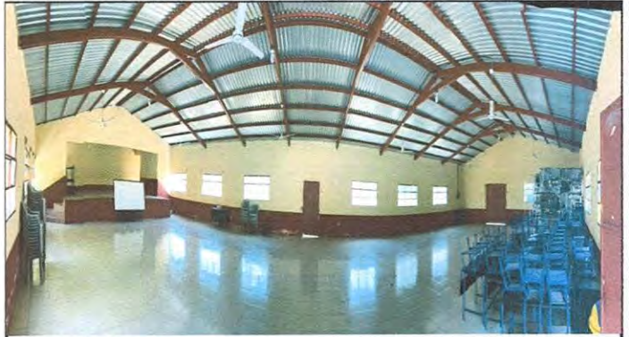
Suministro e Instalacion de cielo falso vinilico de 2*4 + iluminacion (8)
