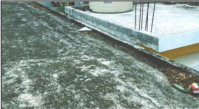
Fundicion de sobre nivel con desnivel hacia los laterales, e impermeabilizacion del mismo para evitar problema de humedad y filtracion hacia el interior de la cocina
