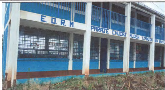
Foto1: Cerco perimetral: Instalación de barandas, parte frontal y lateral del establecimiento
