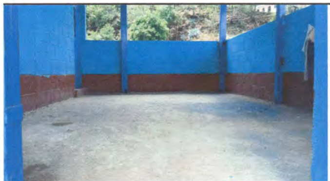
Foto 4: Cocina: Instalación de piso granito
