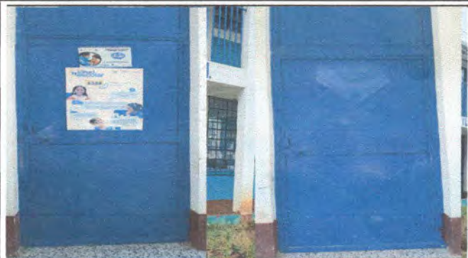
Foto 7: Instalación de chapas para puertas de dirección y dos aulas
