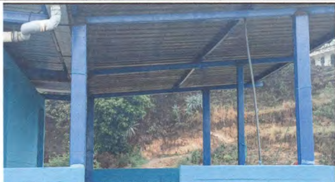
Foto2: Cocina: Instalación de lámina troquelada calibre 26
