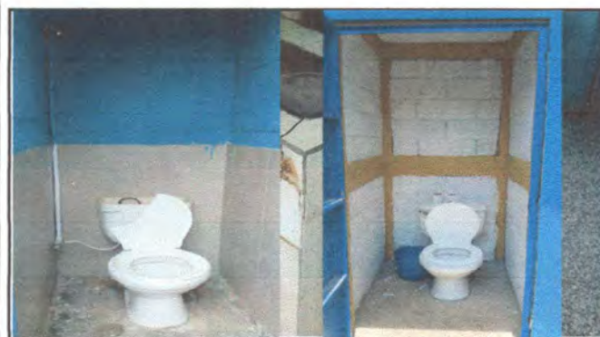
Foto 9: Saniatarios: Instalación de azulejo, piso cerámico, sustitución de accesorios de retretes, (mangueras, tapaderas, y kit de accesorios)
