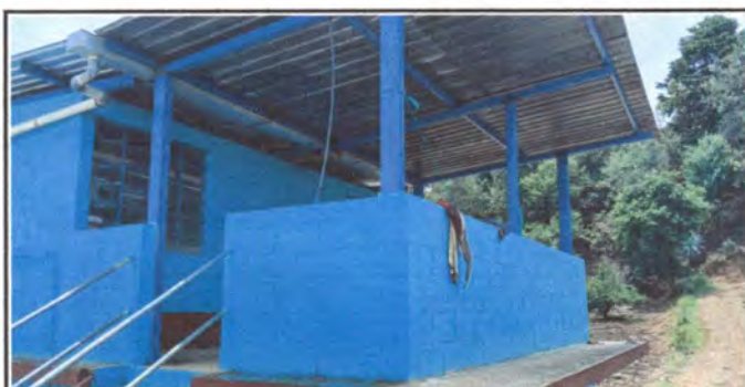
Foto 5: Cocina: Instalación de ventanales
