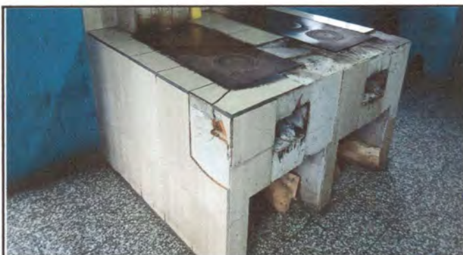
Foto 3: Cocina: Sustitución de plancha.
