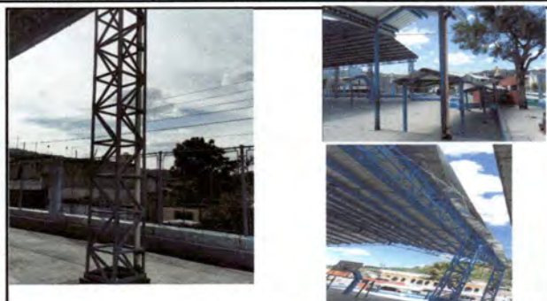
Foto1: Canales y bajadas de agua pluvial
