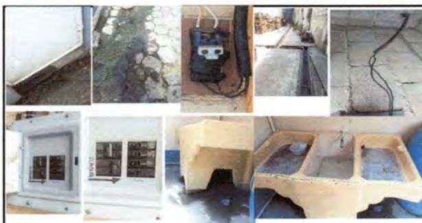
Foto 5: Reparación de red de drenaje y red de agua potable
