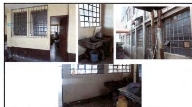
Foto 4: Reparación de cocina
