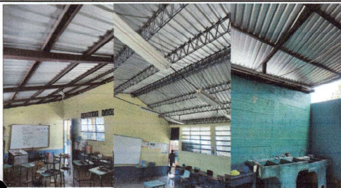
Foto 1: Reparación de sistema eléctrico para: 8 aulas, 3 bodegas, 1 centro de computación, 2 cocinas, 2 servicios sanitarios.
