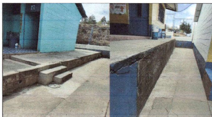
Foto 4: Reparación de repello y cernido de paredes ya que las mismas presentan desboronamiento.
