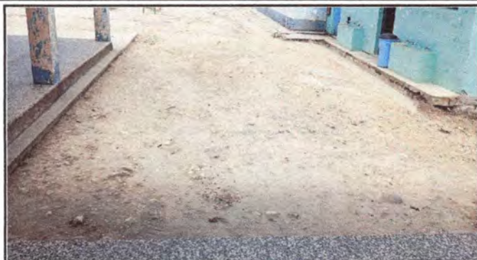
Foto 1: Se colocará adoquines
