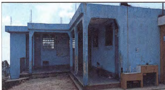
Foto 3: Se pintará las 3 aulas.
