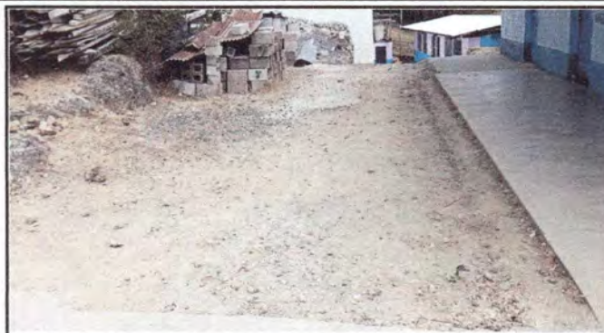
Foto 2: Se colocará adoquines
