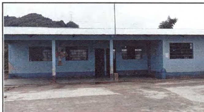
Foto 4: Se pintará y cambiará pisos en las tres aulas.
