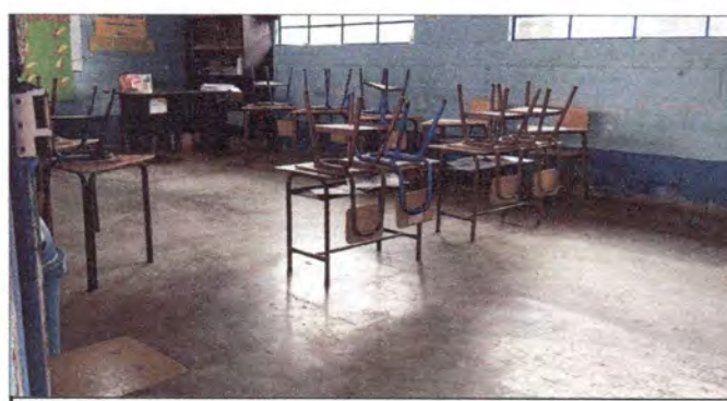
Foto 6: Se cambiara de piso
