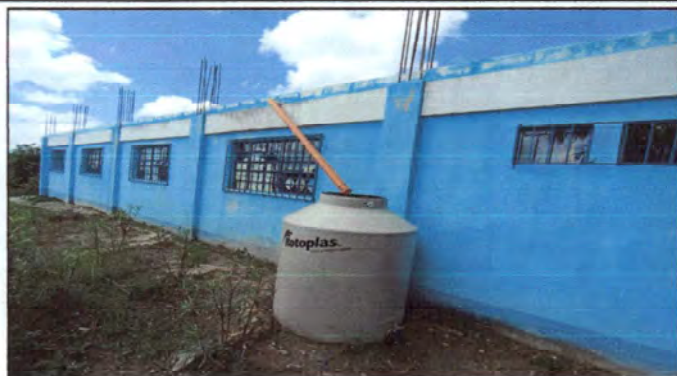
PINTURA DE PAREDES PARTE TRASERA DEL ESTABLECIMIENTO
