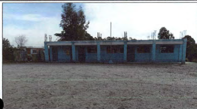
PINTURA DE PAREDES POR FUERA PARTE FRONTAL DEL ESTABLECIMIENTO.
