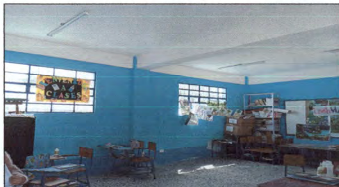
PINTURA DE PAREDES POR DENTRO AULA 2 DEL ESTABLECIMIENTO.
