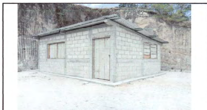
REPELLO DE PAREDES EXTERIOR, SUSTITUCION DE PUERTA DE MADERA POR PUERTA DE METAL, SUSTITUCION DE VENTANAS DE MADERA POR VENTANAS PVC E INSTALACION DE BALCONES DE
