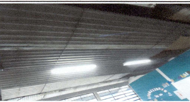
Foto 5: Area de sustitución de cielo falso
