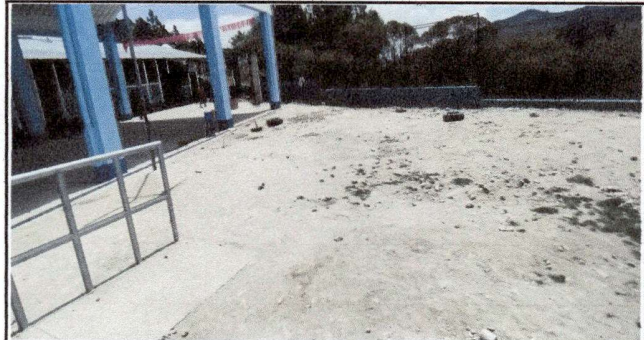
Foto 4: Area de adoquinamiento
