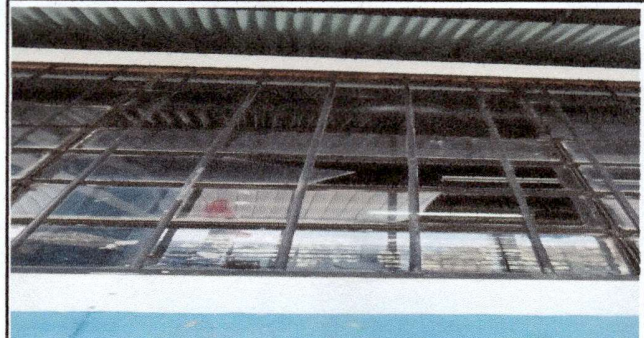
Foto 2: Ventanas a cambiar
