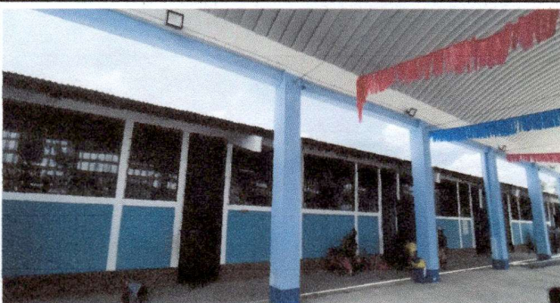
Foto 3: Area donde se colocará los canales
