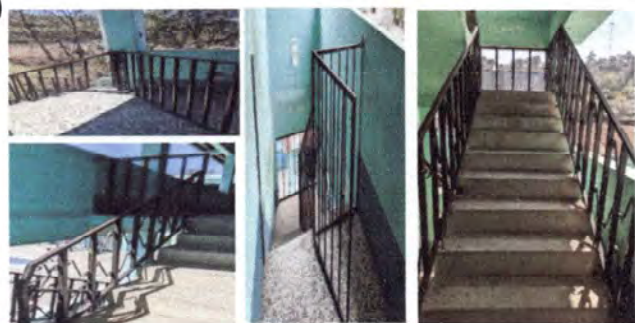
Foto 5: Restauración de barandas de metal de gradass en el tercer y segundo nivel.
