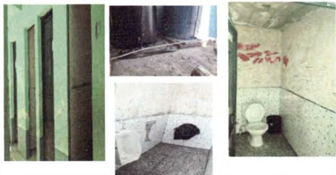
Foto 3: Sustitución de tubería, migitorio y accesorios de tzas lavables y restauración de la pintura de las paredes de los sanitarios.
