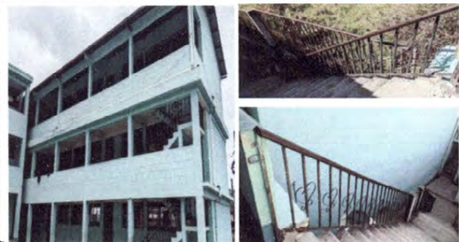
Foto1: Instalación de barandas de metal de acero inoxidable y mantenimiento y pintado de puertas segundo y tercer nivel y instalación de tubos de 3 pulgadas para caída de agua pluvial del tercer nivel.
