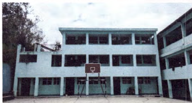
Foto.2 Instalación de barandas de metal de acero inoxidable y mantenimiento y pintado de puertas en el segundo y tercer nivel
