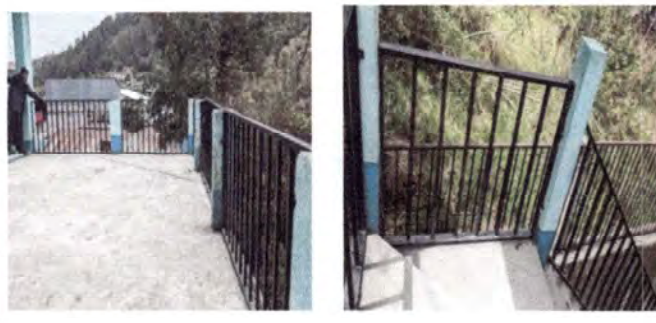
Foto 6: Reforzamiento de barandas de metal y aumentalas 50 centrimetos en el ancho de las mismas en el tercer nivel.
