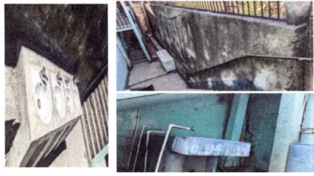
Foto 4: Sustitución de tubería y de accesorios delavamanos en el primer nivel, mantenimiento de muro y pintado y fundación de de torta debajo de la grada y suticion de pila
