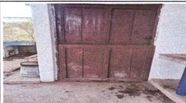
Foto 4: Remozamiento puerta de cocina
