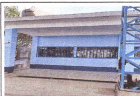
Foto 5: Instalacion de grdas hacia el segundo nivel del establecimiento
