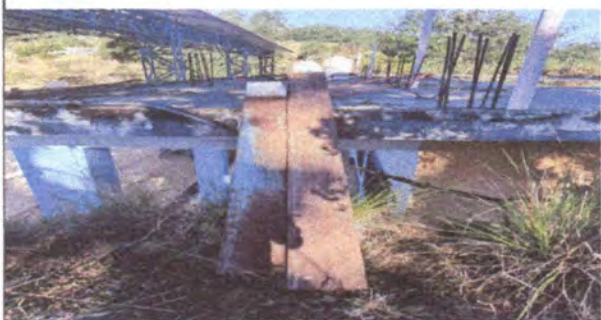
Remozamiento de la losa de la terraza
