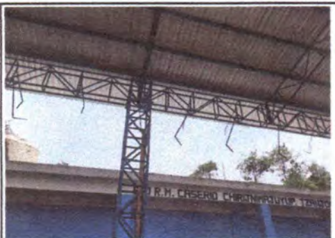
Remozamiento de canales del entechado del establecimiento
