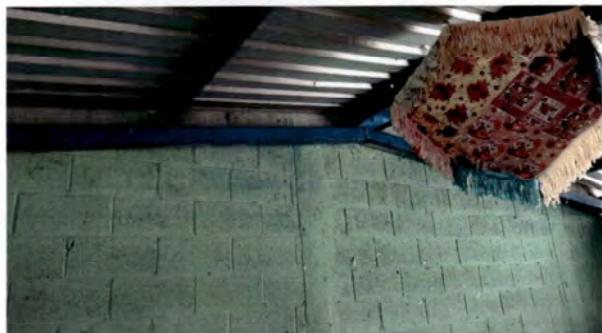
Foto1: Se levanta los mojinets de las dos aulas, cocina y bodega.
