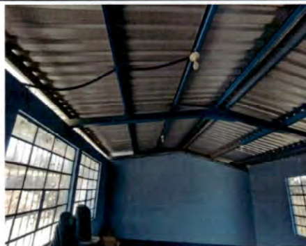
Foto 2: colocacion y pintada de las costaneras.
