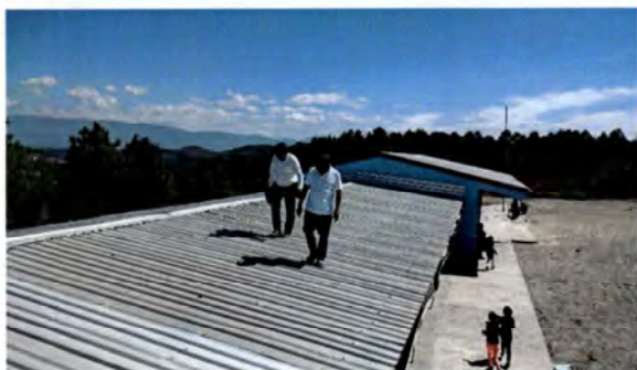
Foto 3: Cambio de laminas de las dos aulas cocina y bodega.
