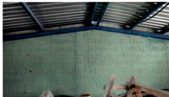
Foto 2: Se amplia los mojinets de la cocina y bodega.
