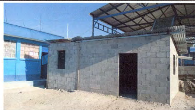
Foto 4: colocación de ventanas, balcones, piso y repello.
