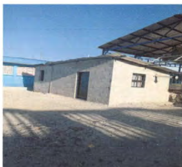
Foto 3: Reparación de cocina, levantada de dos hilada de block y cambio de techo.
